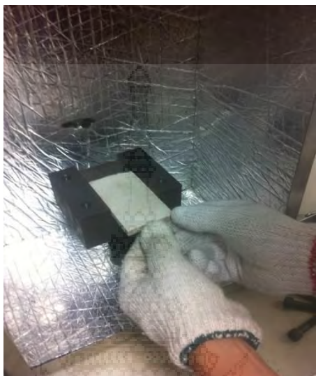
รูปที่ 4.6 การติดตั้งฉนวนเข้ากับแผ่นรองฉนวน
