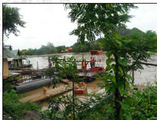
ภาพที่ 3-58 พื้นที่ประกอบอุปกรณ์
