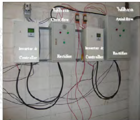
ภาพที่ 2-12 ตู้ควบคุมกระแสไฟฟ้าของกังหันน้ำทั้ง 2 ตัว
