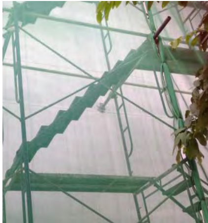
รูปที่ 4.8 ติดตั้งบันไดขึ้น – ลง สำหรับทำงาน
