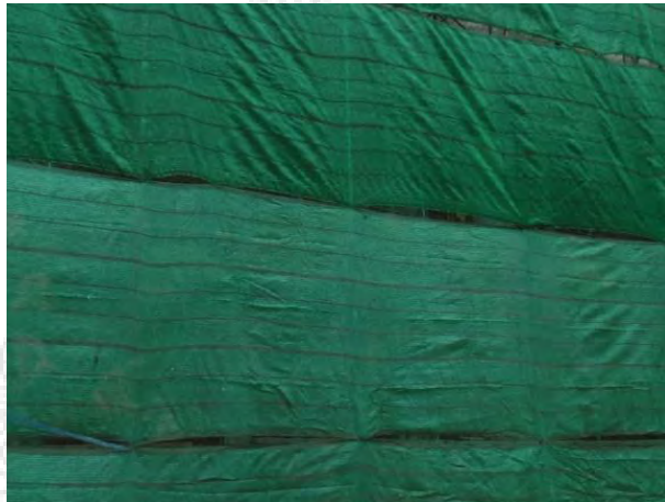
รูปที่ 4.6 ติดตั้งตาข่ายรอบนอกของนั่งร้าน
