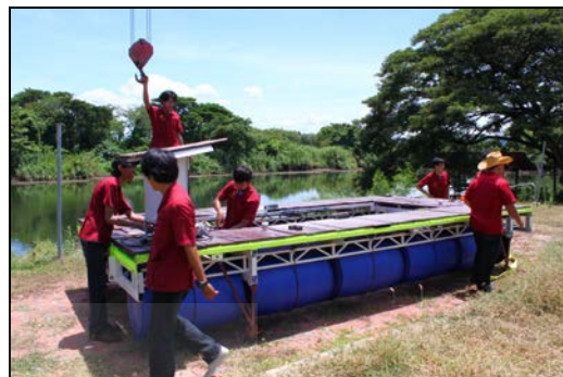
ภาพที่ 3.117 ประกอบเสร็จเตรียมยกลง
