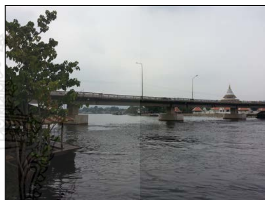
ภาพที่ 3-28 สำรวจบริเวณพื้นที่ทดลองงาน
