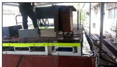
ภาพที่ 3-89 ติดตั้งแบตเตอรี่และอุปกรณ์ทำงานได้
