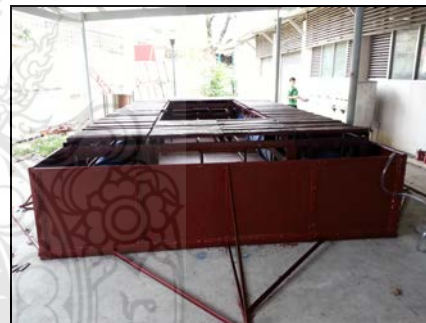
ภาพที่ 3-51 ปิดปากบ่อเชื่อมยึดเหล็กค้ำ
