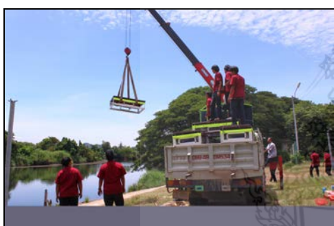
ภาพที่ 3.110 ใช้เครนช่วยยกอุปกรณ์
