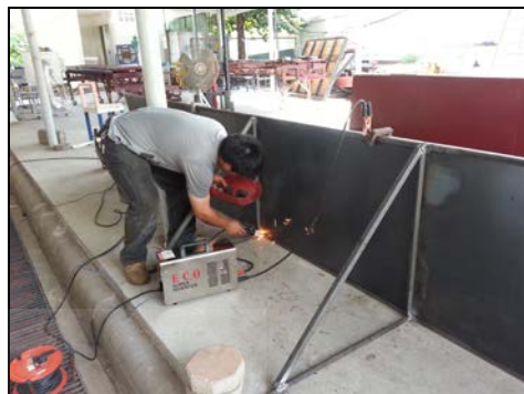
ภาพที่ 3-47 เชื่อมเหล็กค้ำรับแรงดันน้ำด้านนอกผนัง
