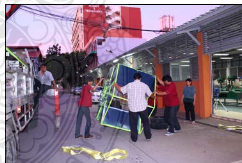
ภาพที่ 3-97 เตรียมใช้อุปกรณ์ช่วยยก
