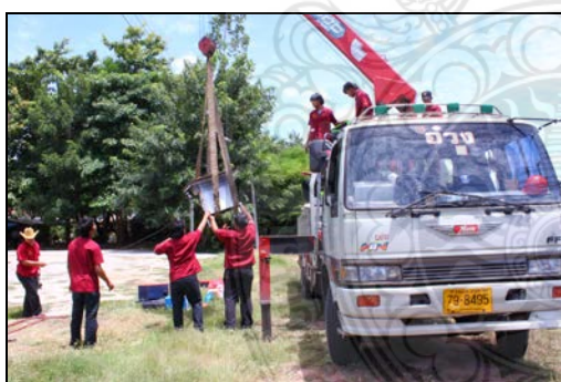
ภาพที่ 3.112 ยกอุปกรณ์ลง
