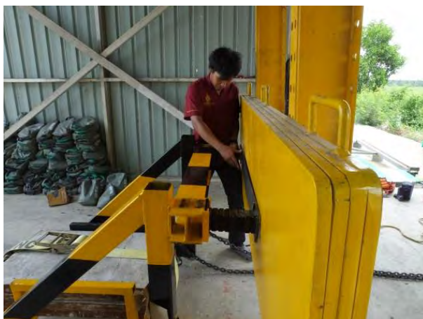
รูปที่ 3.24 การติดตั้งโครงสร้างกันแรงกระแทก
