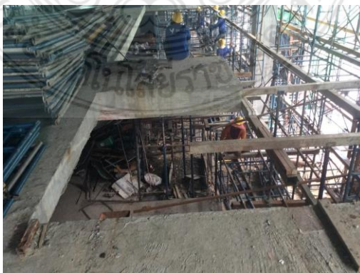
รูปที่ 4.3 ช่องเปิดที่ไม่มีมาตรการป้องกันอันตราย
