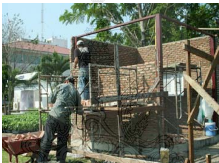
รูปที่ 17 การก่อสร้างอาคารด้วยอิฐก่อสร้างสามัญหรืออิฐมอญที่ผสมดินขาว ณ บริเวณสถานที่ก่อสร้างงานวิจัยบ้านดิน อาคารอนุรักษ์พลังงานและสิ่งแวดล้อม ภาควิชาวิศวกรรมโยธา คณะวิศวกรรมศาสตร์ มหาวิทยาลัยเทคโนโลยีราชมงคลธัญบุรี
