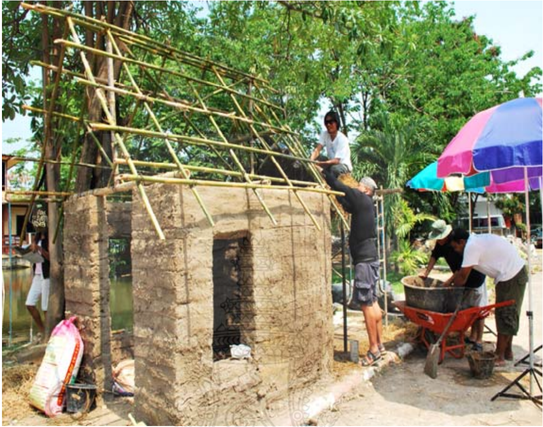
รูป ก่อสร้างด้วยดินขาว
