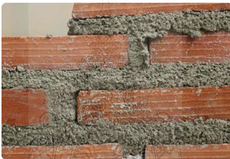
รูปที่ 1 การก่อผนังด้วยอิฐก่อสร้างสามัญหรืออิฐมอญและปูนก่อ
