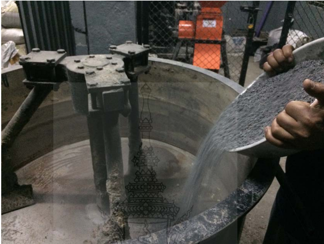
รูปที่ 10 การเทส่วนผสมหินปูนลงเครื่องผสมบดอัดประสาน
