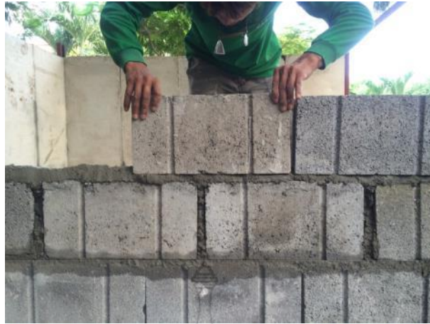
รูปที่ 4.23 ความสามารถในการรับน้ำหนักของคอนกรีตบล็อกผสมเถ้ากะลามะพร้าวเมื่อนำมาก่อเป็นผนัง
