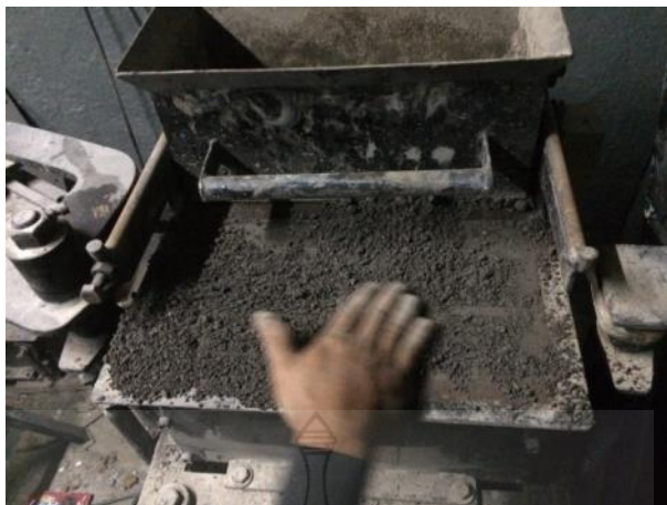
รูปที่ 3.20 การนำส่วนผสมไปใส่ในแบบของเครื่องอัดคอนกรีตบล็อกจนเต็ม
