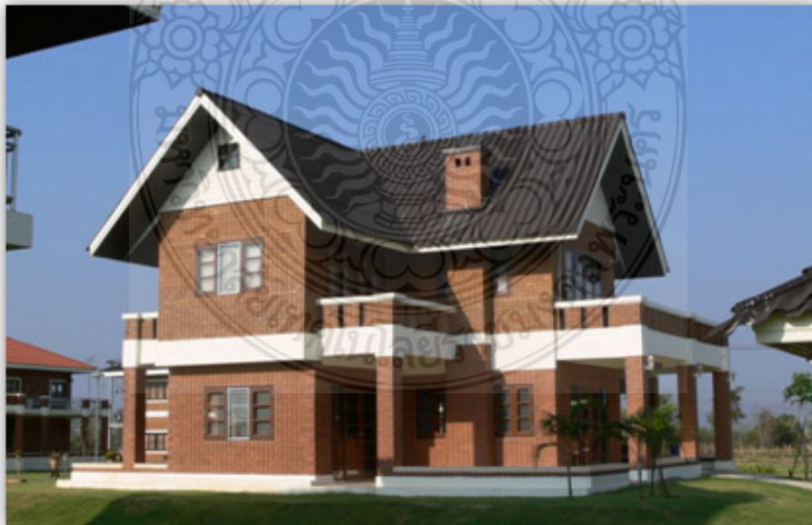
รูป ที่ 2.17 อาคารที่ก่อสร้างด้วยอิฐบล็อกประสานตรง
