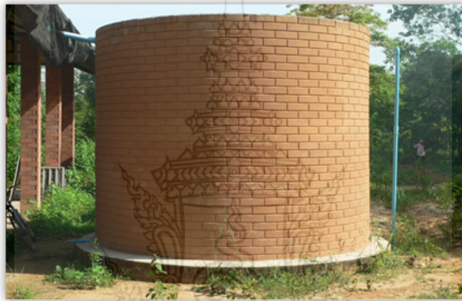
รูป ที่ 2.19 สิ่งก่อสร้างที่ก่อด้วยบล็อกโค้ง
