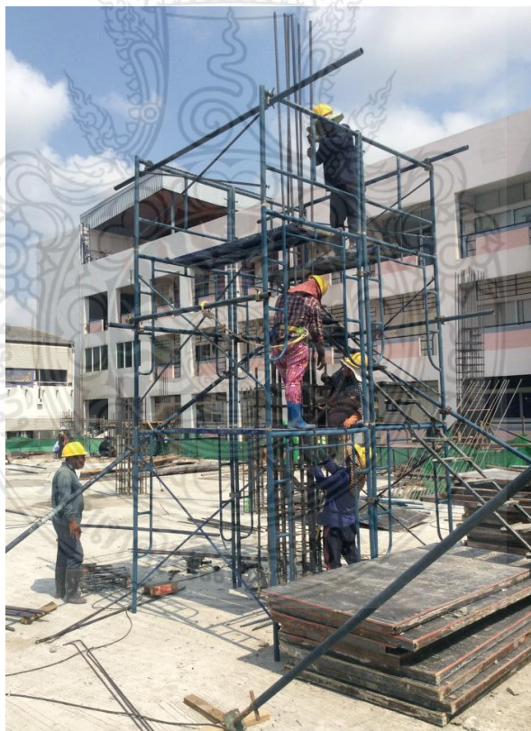
รูปที่ 4.3 มาตรการความปลอดภัยในการทำงานติดตั้งเหล็กเสริมเสา
