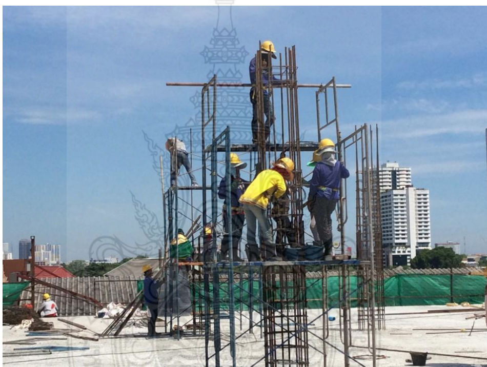
รูปที่ 4.4 สภาพแวดล้อมในการทำงานก่อนนำมาตรการความปลอดภัยมาใช้
