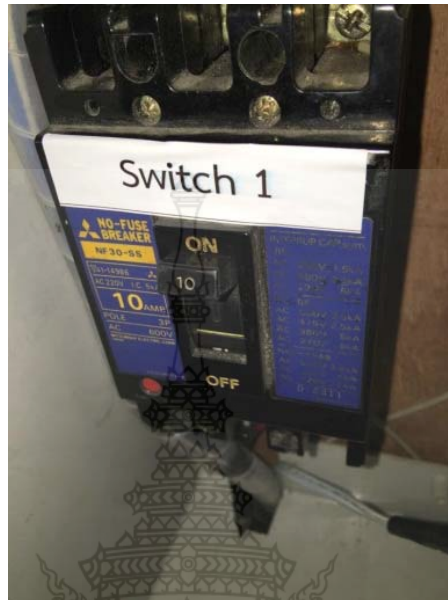
รูปที่ 3.4 สวิตซ์ไฟฟ้า 3 เฟส
