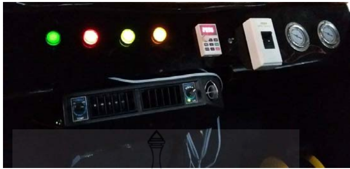
รูปที่ 3.16 ระบบปรับอากาศที่ใช้สำหรับทดสอบ
