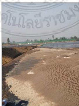
ภาพที่ 4.1 บ่อน้ำเสีย บริษัท น้ำตาลราชบุรี จำกัด
