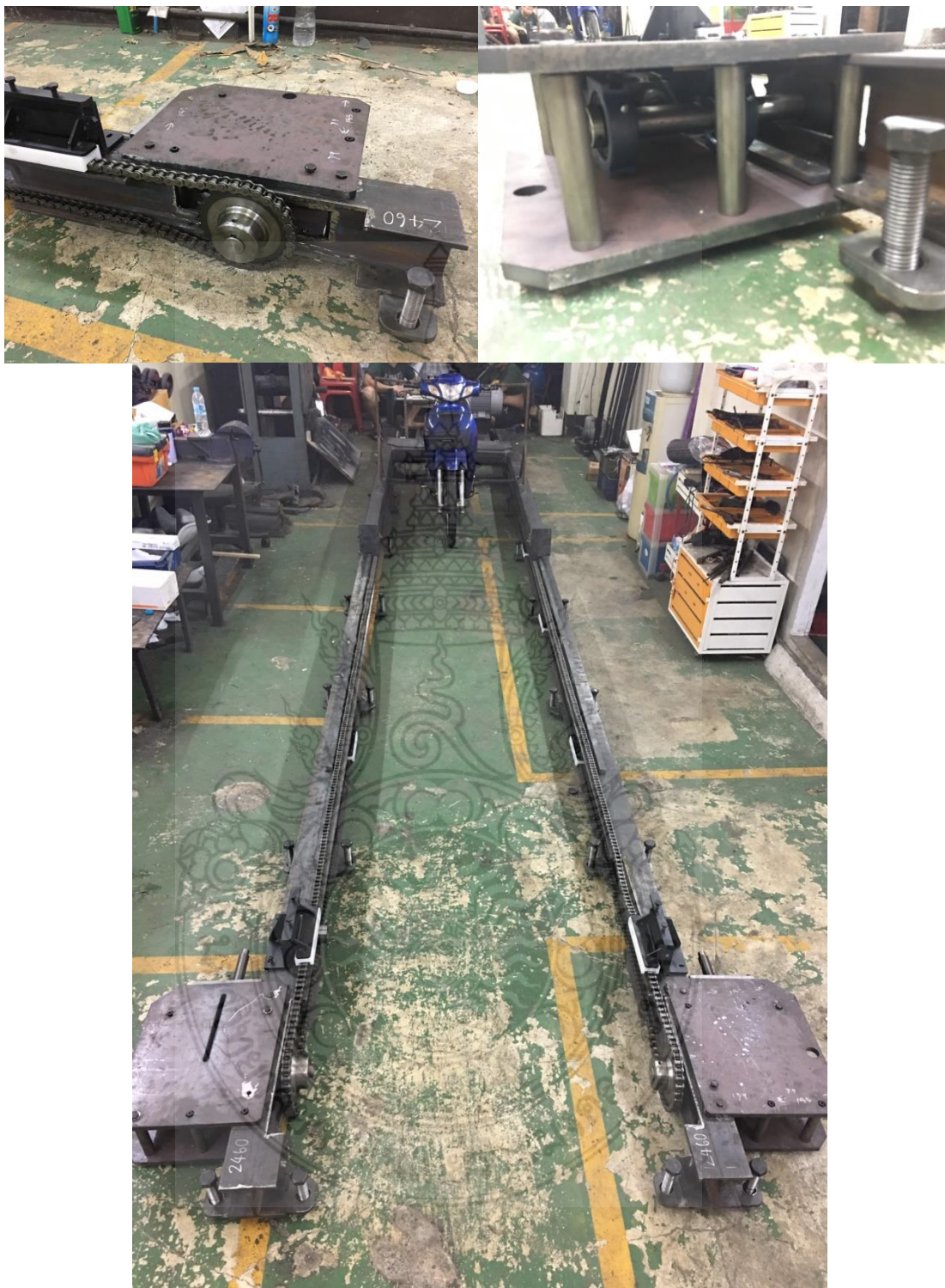
รูปที่ 3.8 การติดตั้งรางเข้าชน
