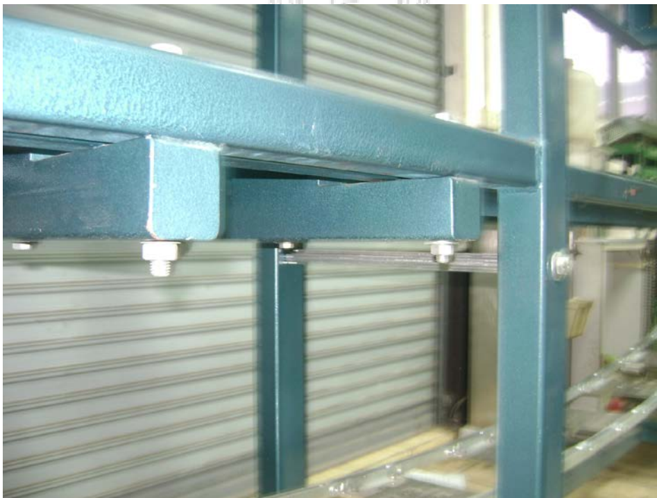
ภาพแสดงด้านล่างใต้สายพานรอกการติดตั้งเตา
