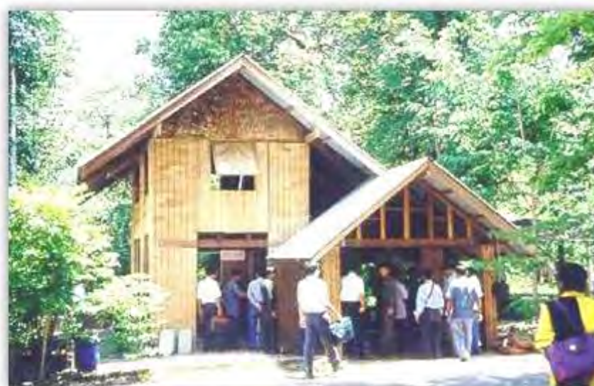
รูปที่ 2.16 อาคารบล็อกประสานหลังแรกสร้าง เมื่อปี พ . ศ . 2527
