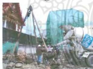
เทคอนกรีตและถอนปลอกเหล็กชั่วคราวกั้นดินพังออก
