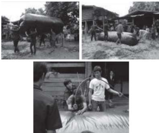
รูปที่ 9 แสดงการนำถุงลงหลุมและการเติมน้ำเข้าสู่ถุงหมัก
