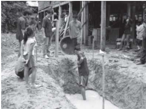
รูปที่ 8 แสดงการทำรางสำหรับวางท่อทางเข้าของมูลและบ่อล้น
