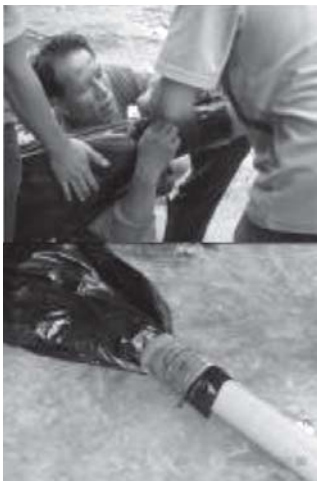
รูปที่ 6 แสดงการผูกท่อพีวีซีด้วยยางในรถจักรยานยนต์
