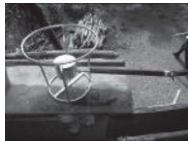
รูปที่ 12 แสดงการติดตั้งท่อส่งแก๊สและวาล์วควบคุมแก๊ส
