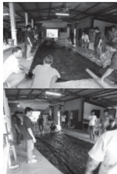
รูปที่ 4 แสดงถุงที่ทำการทากาวและพร้อมในการ ติดตั้งชุดส่งแก๊ส
