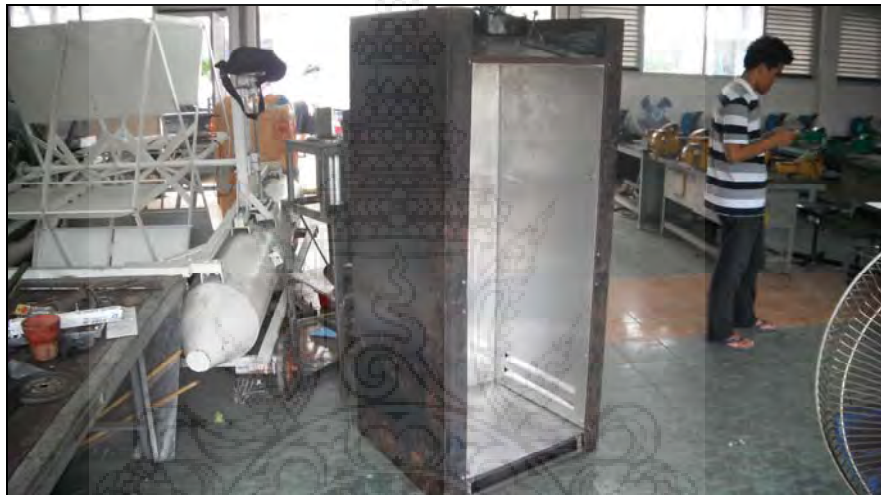
ภาพที่ 3-32 แสดงการประกอบฝาผนังด้านข้างตู้อบ
