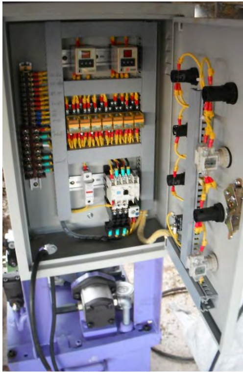
ประกอบชุดควบคุม
