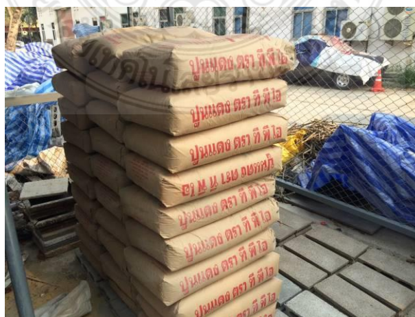
รูปที่ 3.2 ปูนซีเมนต์ปอร์ตแลนด์ประเภทที่ 1
