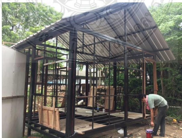
รูปที่ 9 การประกอบแป แผ่นหลังคาเหล็ก โครงผนัง และวงกบ
