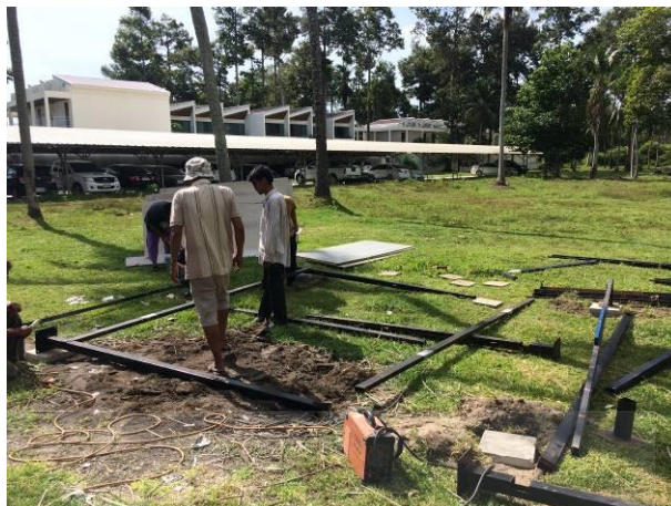
รูปที่ 4.38 การวางผังสำหรับก่อสร้างบ้านถอดประกอบที่ขนส่งสะดวกเพื่อผู้ประสภภัย
