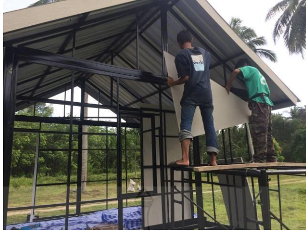
รูปที่ 21 การติดตั้งแผ่นหน้าจั่วเข้ากับโครงหน้าจั่วของบ้านถอดประกอบที่ขนส่งสะดวกเพื่อผู้ประสภภัย
