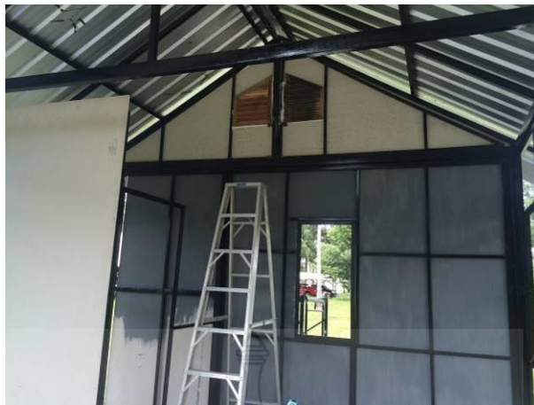
รูปที่ 4.57 การติดตั้งแผ่นผนังด้านในบ้านถอดประกอบสำหรับแบ่งเป็นห้องน้ำ
