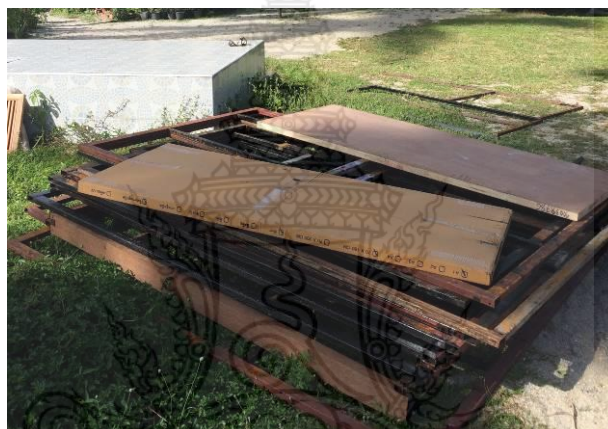
รูปที่ 4.36 การกองเรียงโครงสร้างบ้านถอดประกอบเป็นส่วนๆ
