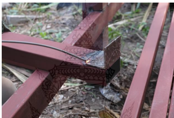
รูปที่ 4.11 การเชื่อมเหล็กฉากเข้ากับคานเหล็กเพื่อให้สามารถร้อยสลักเกลียวได้
