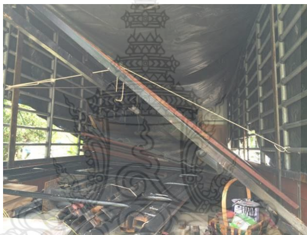
รูปที่ 4.33 โครงสร้างบ้านถอดประกอบที่ถูกคลุมด้วยผ้าใบขณะทำการขนส่งด้วยรถบรรทุก 6 ล้อ
