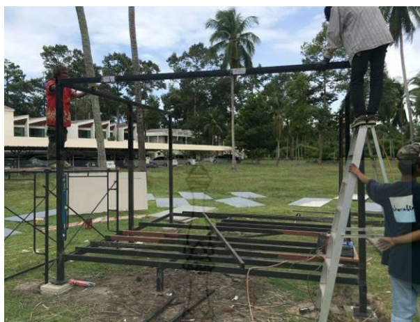
รูปที่ 4.41 การติดตั้งคาน ตง ช่อ และอะเสของโครงสร้างบ้านถอดประกอบ
