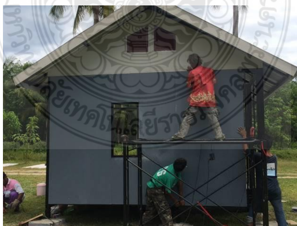
รูปที่ 4.56 การยึดแผ่นผนังที่เว้นช่องหน้าต่างไว้แล้วเข้ากับโครงผนัง
