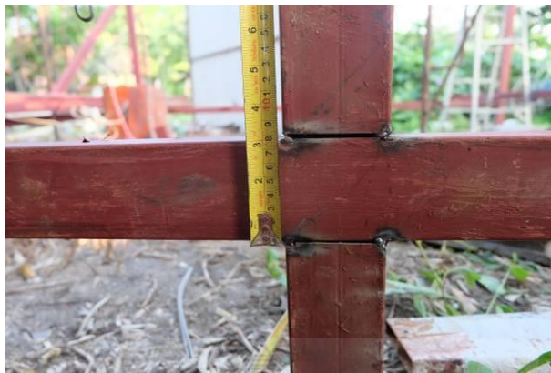
รูปที่ 4.13 การตรวจสอบความสมบูรณ์ของรอยต่อที่บากไว้
