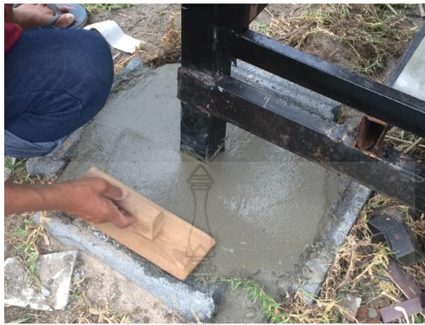
รูปที่ 14 การเทฐานรากหุ้มแผ่นเหล็กและโคนเสาตอม่อเหล็กด้วยคอนกรีตเสริมเหล็ก
