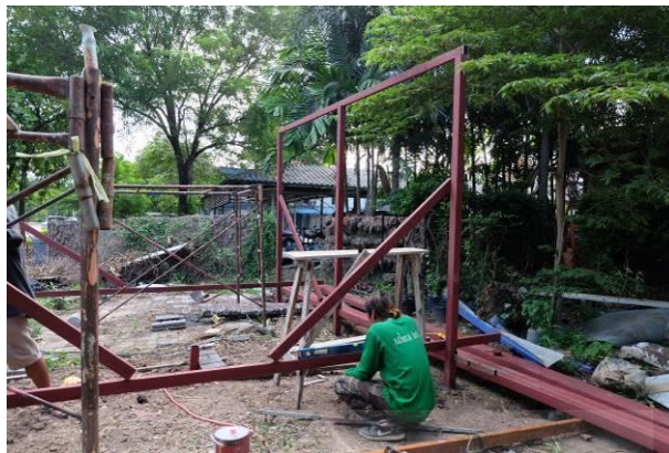
รูปที่ 4.10 การตั้งเสาเหล็กและคานเหล็กให้ได้ระดับ
