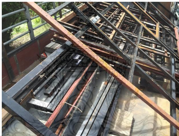
รูปที่ 4.30 การวางโครงผนังพาดเอียงตามแนวกระบะของรถบรรทุก 6 ล้อ
