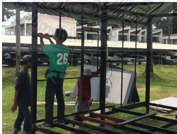
รูปที่ 18 การติดตั้งโครงผนังเข้ากับคานและเสาของบ้านถอดประกอบ
