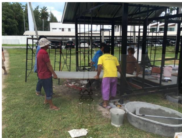
รูปที่ 4.52 การติดตั้งแผ่นพื้นโดยใช้แผ่นซีเมนต์บอร์ดยึดเข้ากับตงและคานเหล็ก
