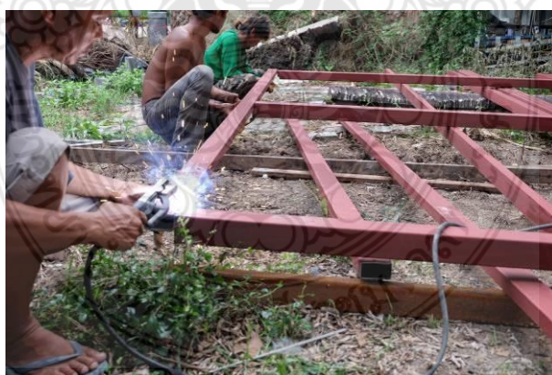
รูปที่ 4.9 การเชื่อมส่วนของโครงสร้างเหล็กเพื่อเตรียมการประกอบ
