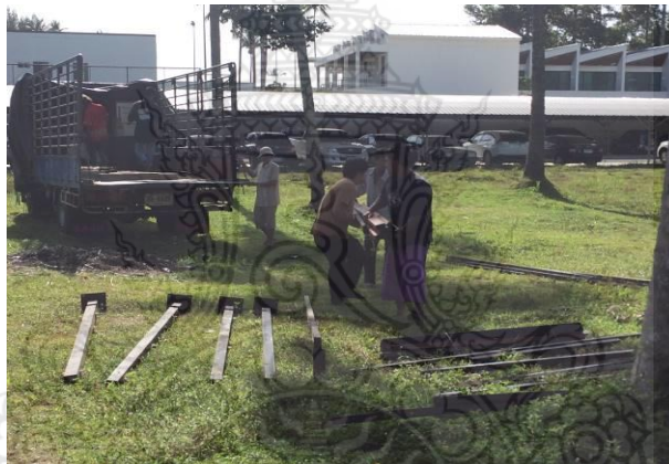
รูปที่ 12 การนำโครงสร้างบ้านถอดประกอบลงจากรถบรรทุก 6 ล้อ
