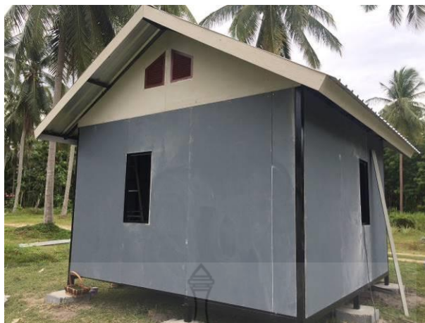
รูปที่ 4.60 การยึดแผ่นผนังเข้ากับโครงผนังของบ้านถอดประกอบทุกด้าน
