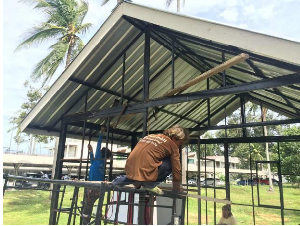
รูปที่ 19 การติดตั้งโครงหน้าจั่วของบ้านถอดประกอบที่ขนส่งสะดวกเพื่อผู้ประสบภัย
