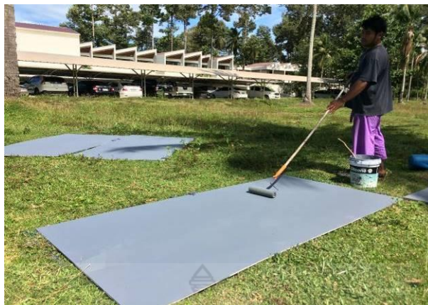
รูปที่ 4.43 การทาสีรองพื้นและสีรอบที่ 1 ให้แผ่นผนัง ระหว่างการติดตั้งโครงสร้างของบ้านถอดประกอบ
