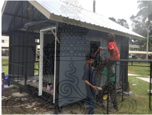
รูปที่ 22 การยัดแผ่นผนังให้ครอบคลุมโครงที่ออกแบบไว้
