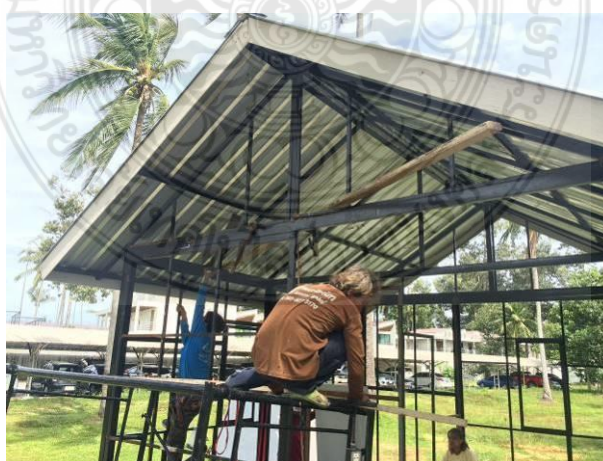
รูปที่ 4.51 การติดตั้งโครงหน้าจั่วของบ้านถอดประกอบที่ขนส่งสะดวกเพื่อผู้ประสบภัย
