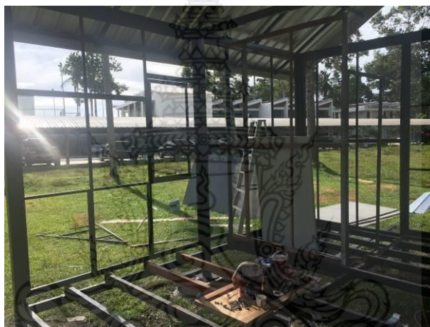
รูปที่ 4.50 การติดตั้งโครงผนังด้านในเพื่อกันเป็นห้องน้ำ
