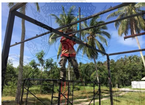
รูปที่ 4.44 การเตรียมติดตั้งออกไก่บนดั่งของโครงหลังคา
