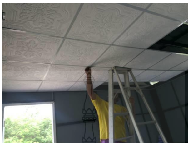
รูปที่ 4.63 การติดตั้งฝ้าเพดานโดยใช้โครงอะลูมิเนียมแบบทีบาร์และแผ่นฝ้าเพดานยิปซัม
