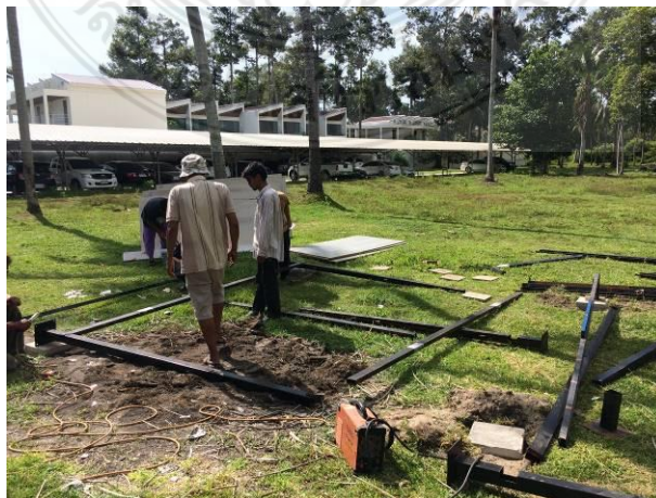
รูปที่ 13 การปรับพื้นที่ก่อสร้างบ้านถอดประกอบให้เรียบ
