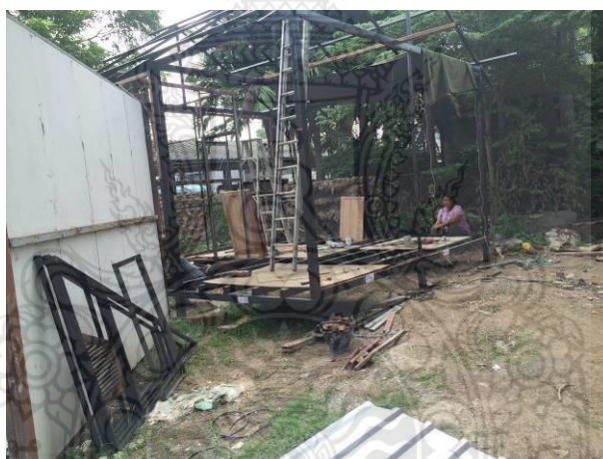
รูปที่ 4.23 การเริ่มรื้อถอนโครงสร้างบ้านถอดประกอบเพื่อเตรียมขนส่งไปติดตั้งในสถานที่ก่อสร้าง
