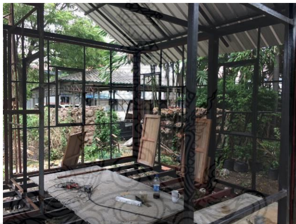
รูปที่ 4.20 การทดลองติดตั้งส่วนต่างๆ ของโครงสร้างบ้านถอดประกอบที่ขนส่งสะดวก
