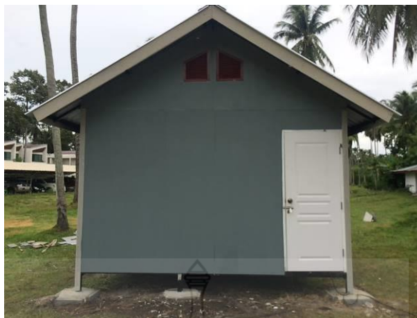
รูปที่ 4.65 ด้านหน้าของบ้านถอดประกอบที่ขนส่งสะดวกเพื่อผู้ประสบภัย
