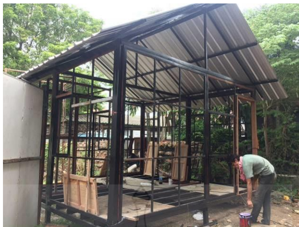
รูปที่ 4.19 การประกอบแปะ แผ่นหลังคาเหล็ก โครงผนัง และวงกบ
