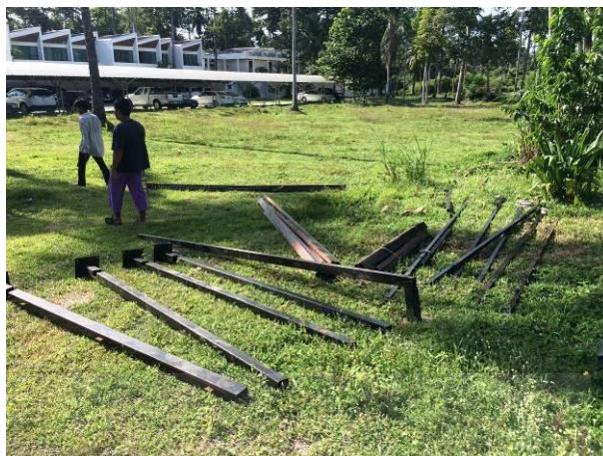
รูปที่ 4.35 การวางเรียงโครงสร้างบ้านถอดประกอบเป็นส่วนๆ อย่างเป็นระเบียบ
