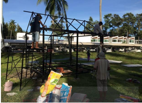
รูปที่ 16 การติดตั้ง ออกไก่ และจันทันของโครงสร้างหลังคาเรียบร้อยแล้ว
