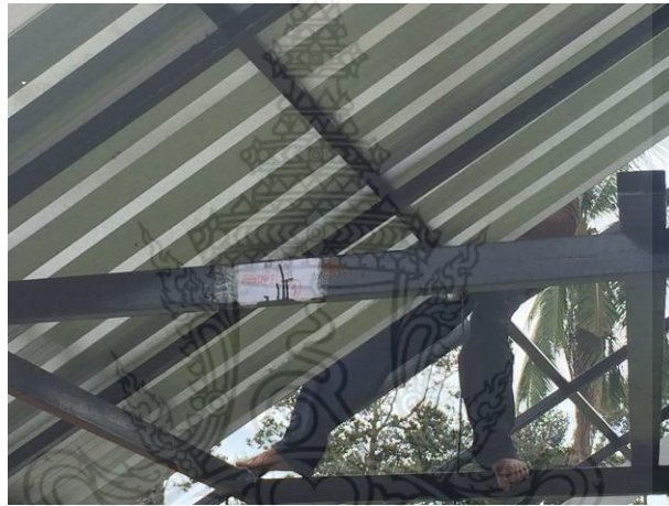
รูปที่ 17 แผ่นหลังคาเหล็กที่ถูกยึดเข้ากับโครงสร้างหลังคาด้วยตะปูเกลียวที่มียางรองการรั่วซึม
