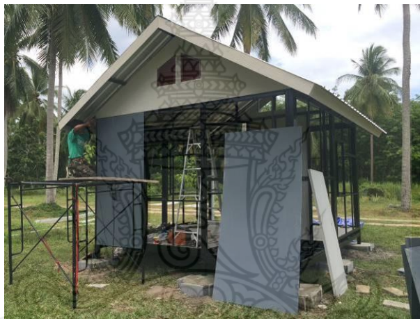
รูปที่ 4.55 การติดตั้งแผ่นผนังเข้ากับโครงผนังของบ้านถอดประกอบที่ขนส่งสะดวกเพื่อผู้ประสบภัย
