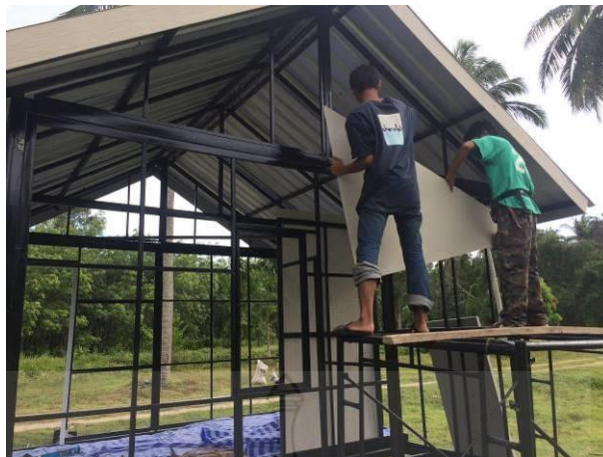
รูปที่ 4.54 การติดตั้งแผ่นหน้าจั่วเข้ากับโครงหน้าจั่วของบ้านถอดประกอบที่ขนส่งสะดวกเพื่อผู้ประสบภัย
