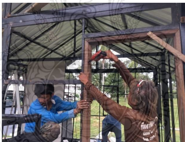
รูปที่ 4.53 การติดตั้งวงกบประตูโดยยึดเข้ากับโครงสร้างด้วยตะปูเกลียวปลายปล้อย
