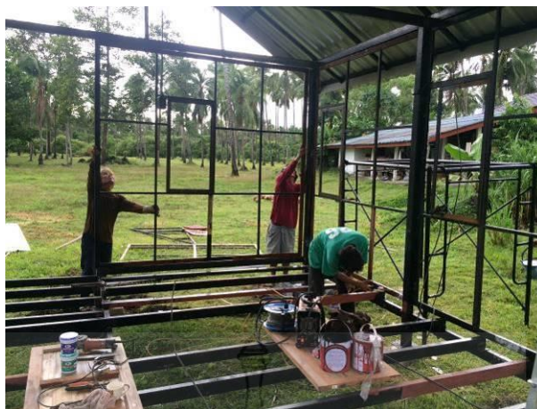
รูปที่ 4.49 การใช้สลักเกลียวยึดโครงผนังเข้ากับเสาและคานของบ้านถอดประกอบ
