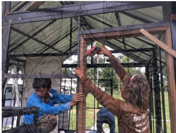
รูปที่ 20 การติดตั้งวงกบประตูโดยยึดเข้ากับโครงสร้างด้วยตะปูเกลียวปลายปล้อย
