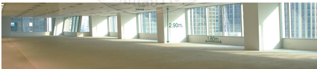
ภาพที่ 2 พื้นที่สำนักงาน Office
