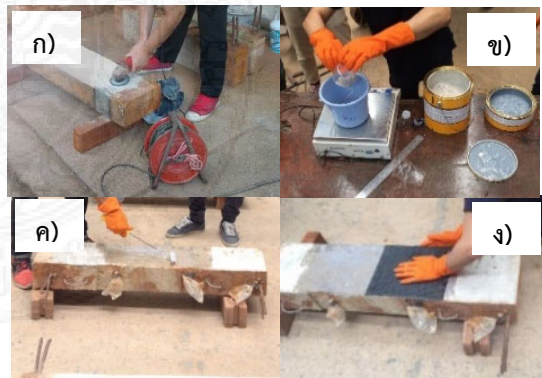
รูปที่ 4 แสดงการติดตั้งแผ่นคาร์บอนไฟเบอร์
