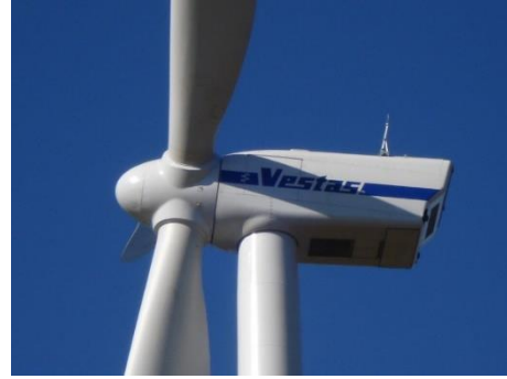
รูปที่ 11 กังหันลมผลิตไฟฟ้ายี่ห้อ Vestas V90 ขนาดกำลังการผลิต 3 เมกกะวัตต์ [10]
