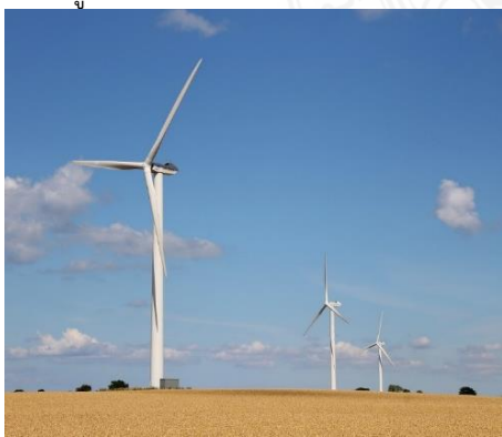
รูปที่ 10 กังหันลมผลิตไฟฟ้ายี่ห้อ Nordex N50 ขนาดกำลังการผลิต 800 กิโลวัตต์ [9]
