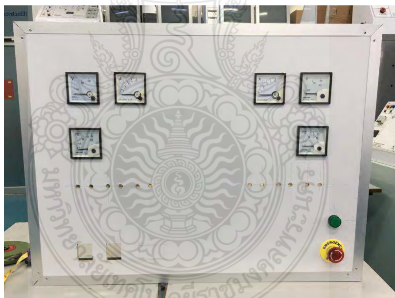
ภาพที่ 3.5 การติดตั้งอุปกรณ์ เครื่องมือวัดทางไฟฟ้า
