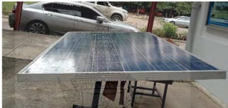
รูปที่ 3.14 ทำการติดตั้งแผงโซลาร์เซลล์ทำมุมที่ 15 องศา
