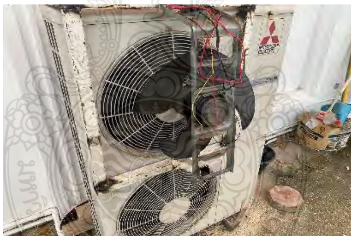
ภาพที่ 3.7 แสดงถึงการประกอบโครงเหล็กและอุปกรณ์เข้ากับเครื่องระบายความร้อนของเครื่องปรับอากาศ
