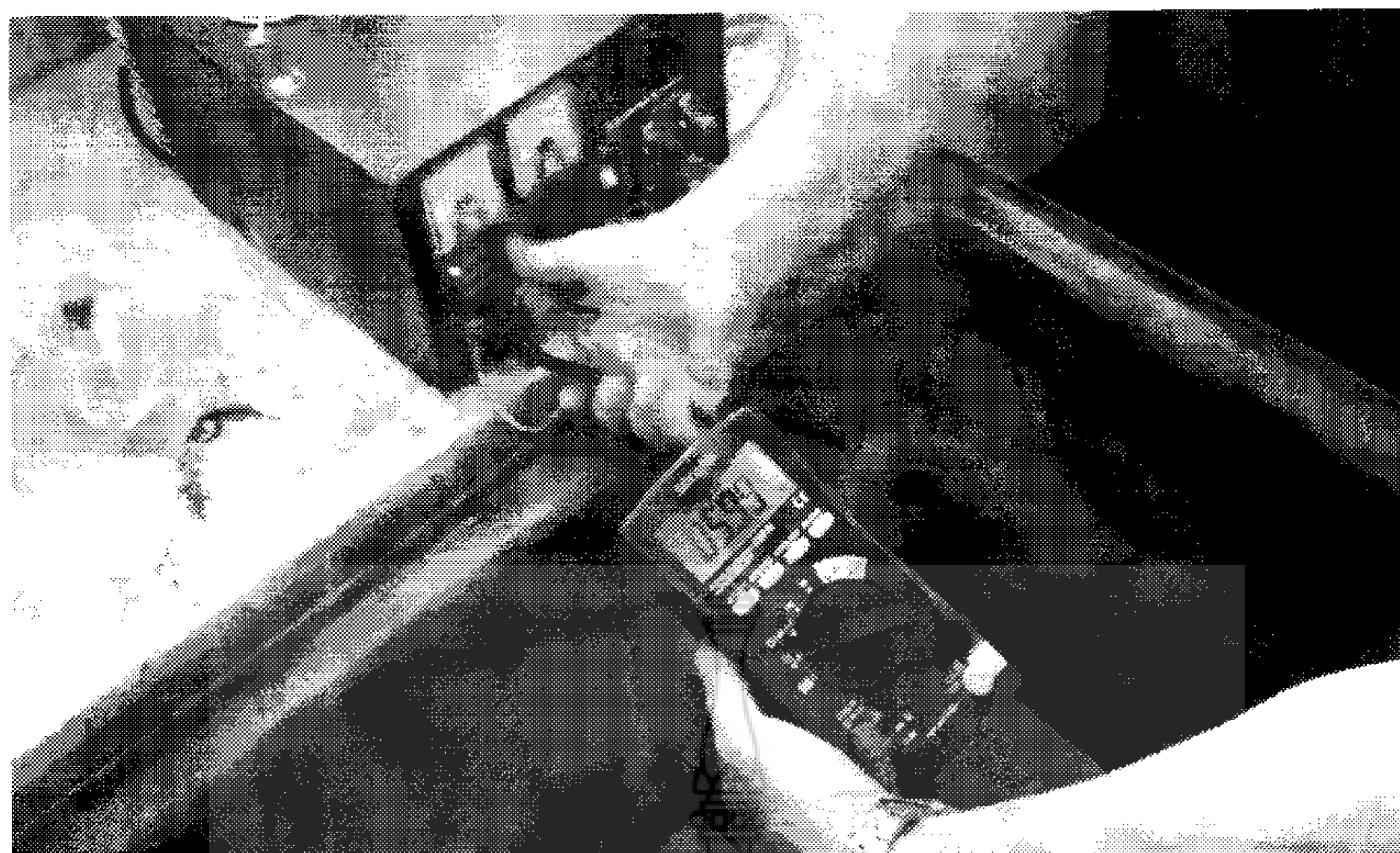
รูปที่ 3.12 การตรวจสอบความสม่ำเสมอของกระแสไฟฟ้า
