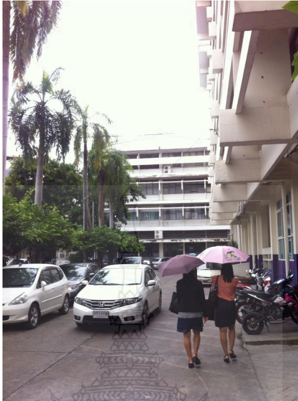
ภาพที่ 2.13 ลักษณะกายภาพของอาคารและทางเดิน
