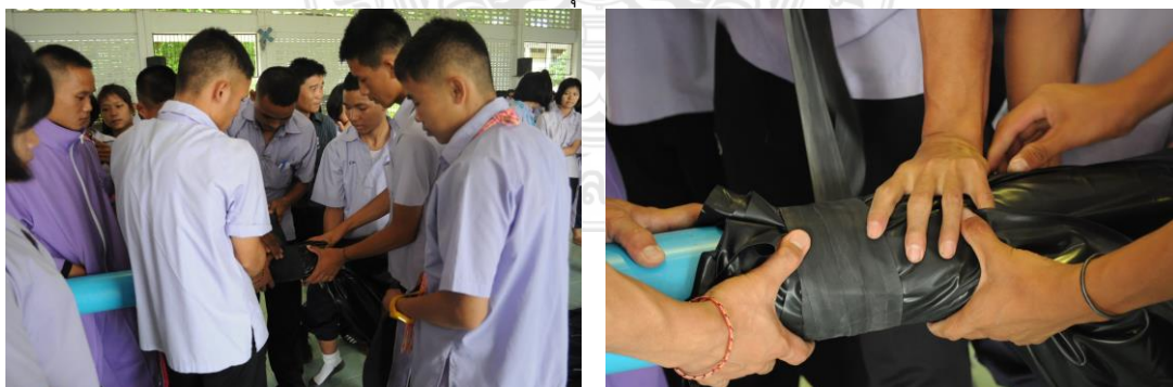
รูปที่ 5 การผูกท่อพีวีซีด้วยยางในรถจักรยานยนต์
