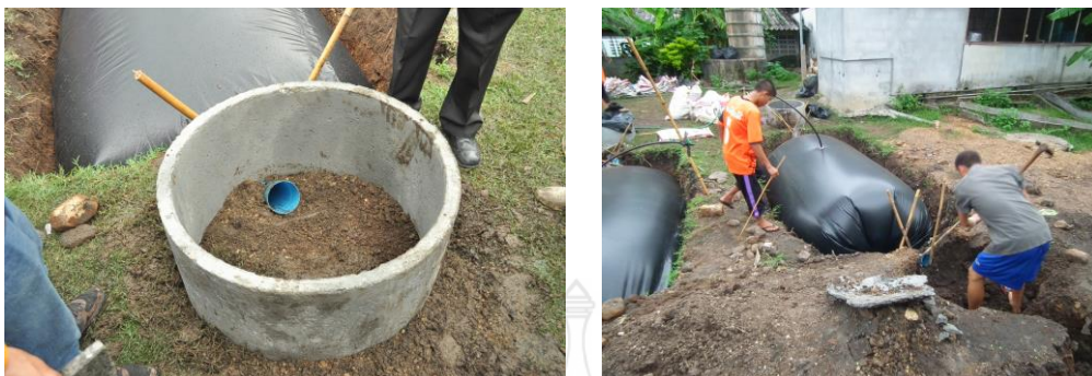
รูปที่ 8 การทำบ่อทางเข้าของมูลและบ่อล้นทางออก
