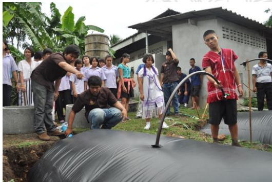
รูปที่ 7 การนำถุงลงหลุมและการเติมน้ำเข้าสู่ถุงหมัก
