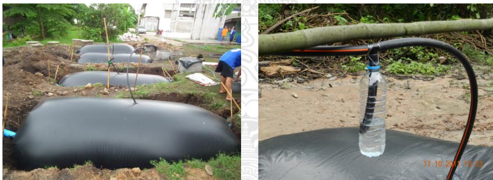
รูปที่ 9 การประกอบสายส่งแก๊ส พร้อมทั้งติดตั้งขุดปรับแรงดันและดักน้ำ
