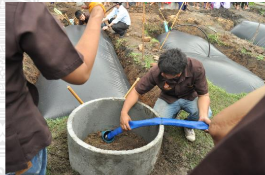
รูปที่ 7 การนำถุงลงหลุมและการเติมน้ำเข้าสู่ถุงหมัก
