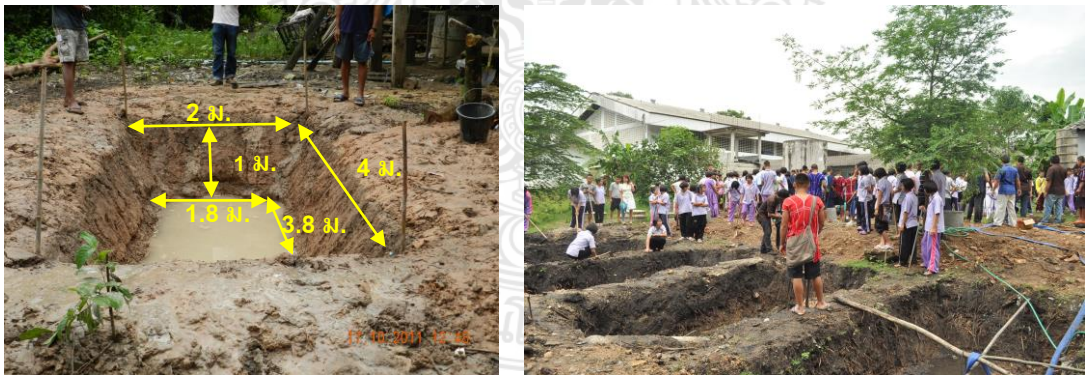
รูปที่ 2 การจัดเตรียมพื้นที่สำหรับวางถุหมักแก๊สชีวภาพ
