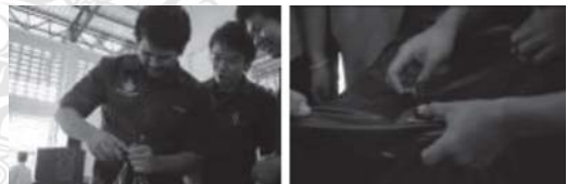
รูปที่ 4 การติดตั้งชุดส่งแก๊สจากตัวถุงหมักพีวีซี
