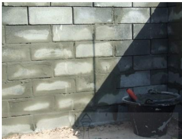
รูปที่ 4.17 การก่อผนังด้วยอิฐบล็อกประสานหน้าดินชาวผสมเศษกระดาศกล่อนนมอัตราส่วน P0.80
