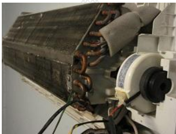
รูปที่ 9 มอเตอร์ไฟฟ้ากระแสตรงที่ใส่แทนมอเตอร์ตัวเดิม
