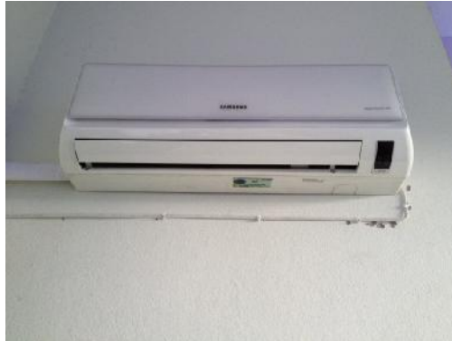
รูปที่ 2 ภาพติดตั้งคอยล์เย็นภายในห้อง
