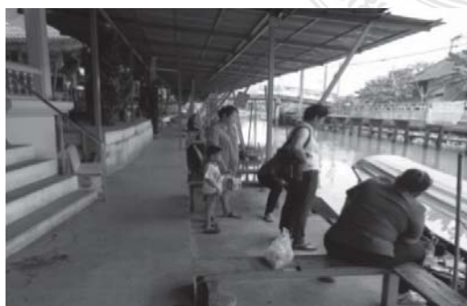
รูปที่ 3 แสดงพื้นที่ทางเดินบริเวณริมน้ำมีระดับต่ำกว่าพื้นที่บนบกประมาณ 80 เซนติเมตร
