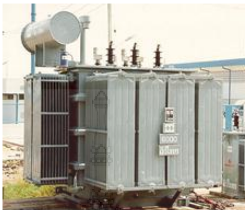
ภาพ 2.2 หม้อแปลงไฟฟ้าชนิด Open type Conservator
