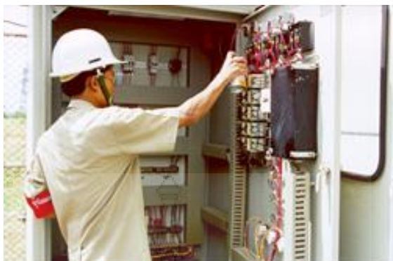
ภาพ 2.7 แสดงการให้บริการตรวจสอบหม้อแปลงไฟฟ้ากำลังขนาด 50 MVA การไฟฟ้านครหลวง
