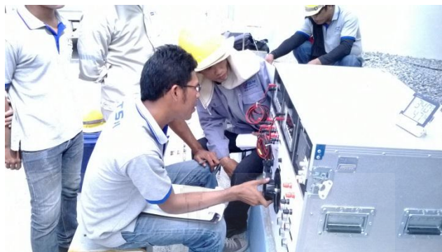
ภาพ 4.4 ทดสอบค่า Leakage Impedance 1 เฟส
