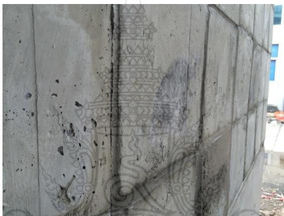
รูปที่ 4.22 ลักษณะผนังแผ่นซีเมนต์บอร์ดจากกากกาแฟที่มีการฉาบรอยต่อด้วยกาวซีเมนต์
