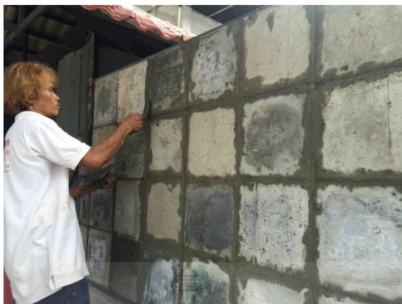
รูปที่ 4.21 การฉาบปิดรอยต่อแผ่นซีเมนต์บอร์ดจากกากกาแฟด้วยกาวซีเมนต์
