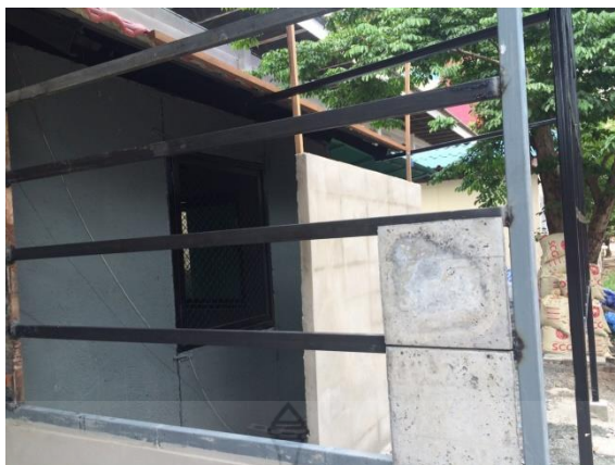
รูปที่ 4.18 โครงคร่าวเหล็กสำหรับติดตั้งแผ่นซีเมนต์บอร์ดจากกากกาแฟ
