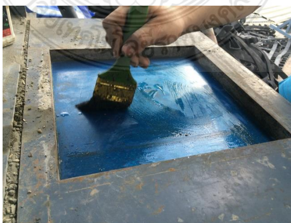
รูปที่ 3.17 การรองแผ่นพลาสติกและทาน้ำมันหล่อลื่นบนแบบหล่อแผ่นซีเมนต์บอร์ด
