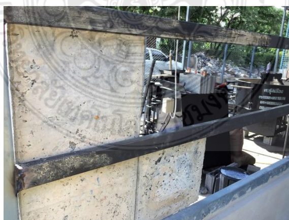
รูปที่ 4.18 ด้านหลังโครงคร่าวเหล็กที่มีการติดตั้งแผ่นซีเมนต์บอร์ดจากเก้าะลามะพร้าว
