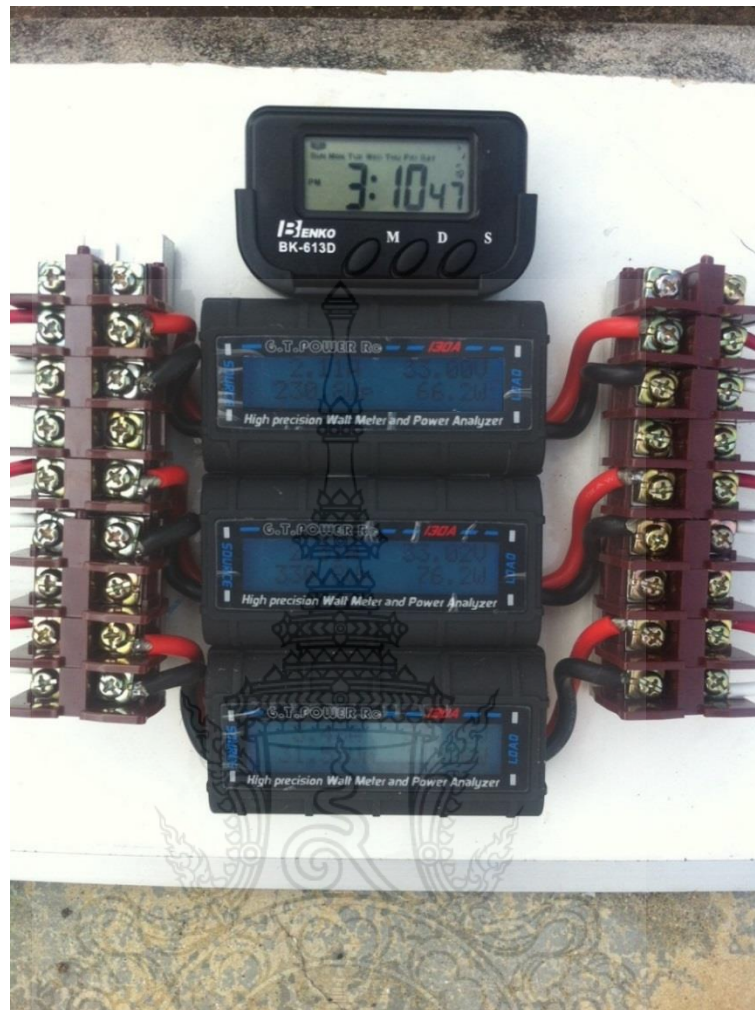
ภาพภาคผนวก ค 1 การติดตั้งเครื่องวัด Watt Meter
