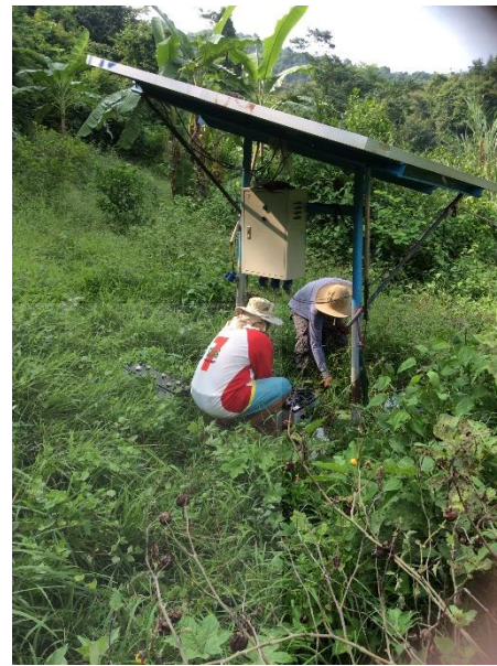
ภาพ 7.6 โซลาร์เซลล์ที่ทำการติดตั้ง
