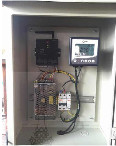
ภาพ 3.23 ชุดตู้อุปกรณ์ตรวจวัดและส่งสัญญาณแจ้งเตือนค่าน้ำเค็ม
