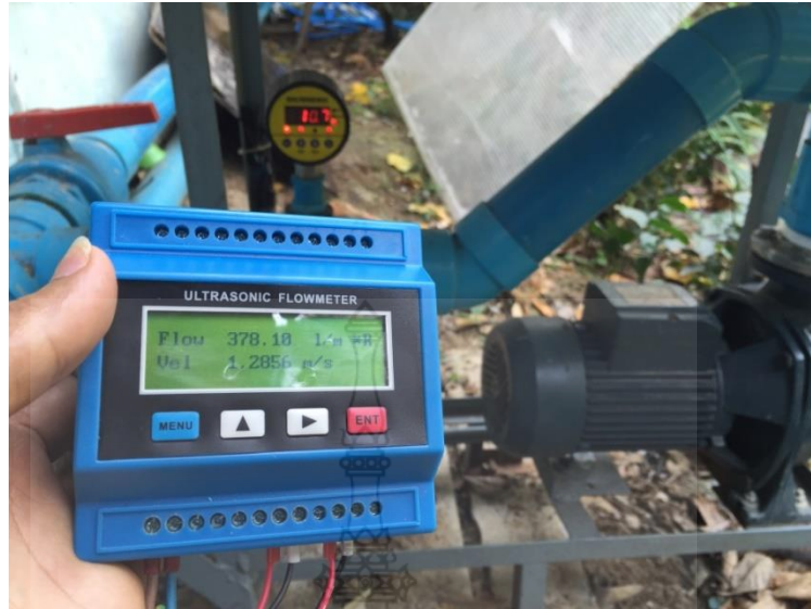
ภาพ 4.8 การทดสอบค่าแรงดันน้ำและอัตราการไหลของน้ำ
