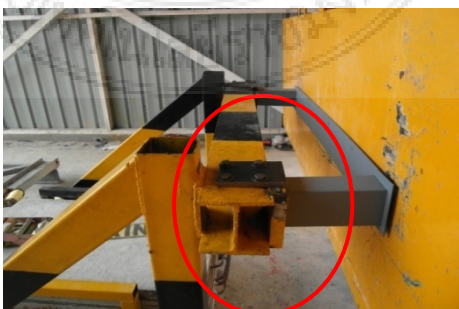
รูปที่ 3.25 การติดตั้งโครงสร้างกันแรงกระแทก
