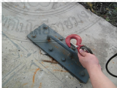
รูปที่ 5 คล้องตะขออีกด้านหนึ่งของปลายเคเบิลตัวที่ 2
