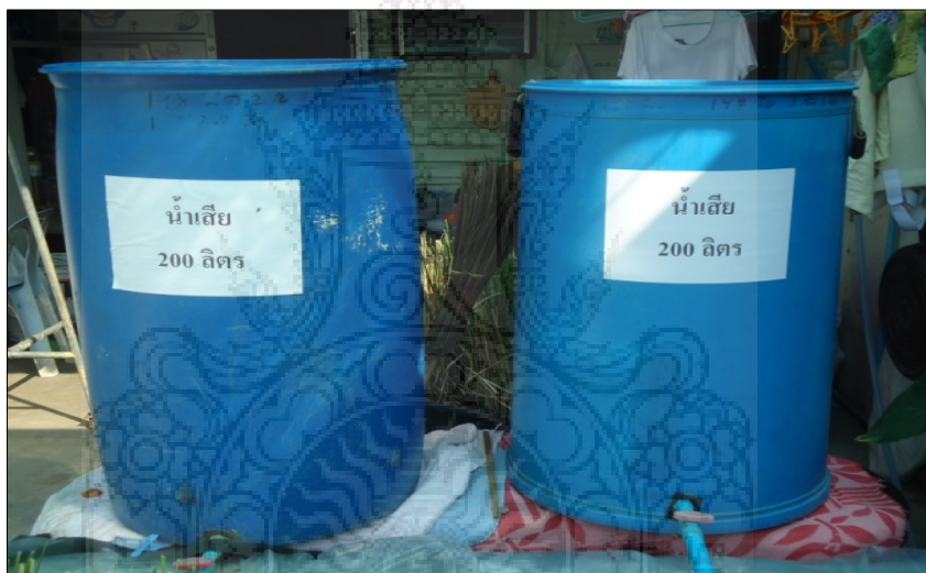
ภาพ 3.15 แสดงถังกระจายน้ำเสีย
