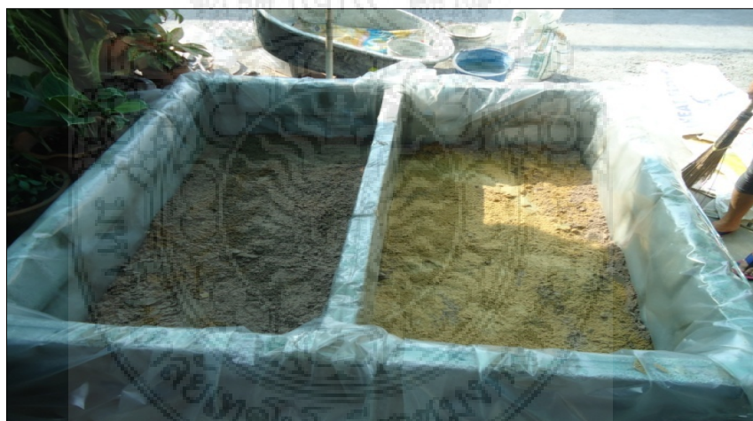
ภาพ 3.7 แสดงชั้นทรายในระบบบำบัดน้ำเสียด้วยเทคนิคแทนลอยน้ำ
