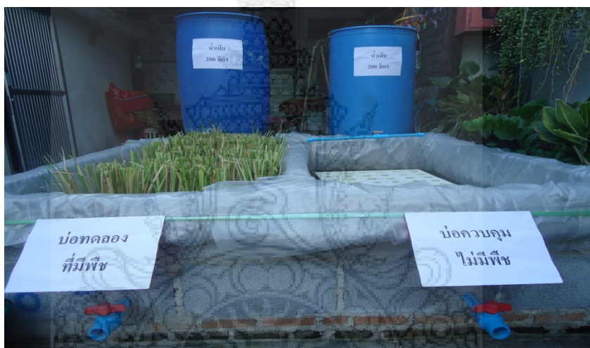
ภาพ 3.18 แสดงระบบบำบัดน้ำเสียด้วยเทคนิคแทนลอยน้ำ
