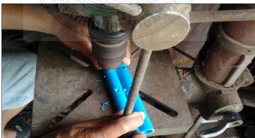
ภาพ 3.16 แสดงการเจาะรูท่อกระจายน้ำเสีย
