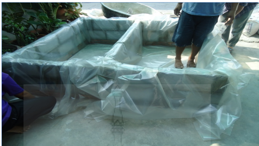
ภาพ 3.6 แสดงบ่อทดลองปูด้วยพลาสติกกันน้ำซึม
