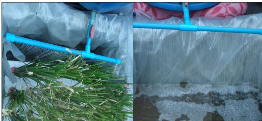
ภาพ 3.17 แสดงการปล่อยน้ำเข้าระบบบำบัดน้ำเสียด้วยเทคนิคแทนลอยน้ำ
