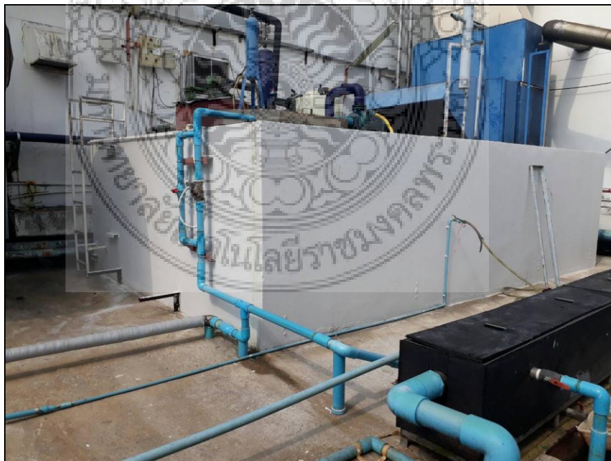
ภาพ 4.5 การต่อท่อน้ำเสียโดยใช้ท่อพีวีซี ขนาด 4 นิ้ว ต่อมาจากรางรึมน้ำเสียในไลน์ผลิต ตรงการของท่อจะใส่สามทางเพื่อต่อวาวส์ไว้เพื่อทำการปล่อยน้ำเสียลงรางได้ โดยตรงไม่ต้องผ่านเครื่องแลกเปลี่ยนได้
