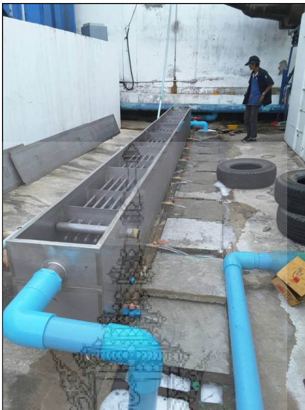
ภาพ 4.3 ทำการติดตั้งถังของตัวเครื่องแลกเปลี่ยนความร้อน ใกล้กับท่อน้ำทิ้งจากโรงงานเพื่อให้ น้ำเสียไหลเข้าเครื่อง ด้วยการไหลจากที่สูงลงสู่ที่ต่ำ ให้ด้านข้างออกไหลลงรางทิ้งน้ำเสีย โดยหันด้านรูน้ำทิ้งจากการล้างไหลลงสู่รางด้านข้าง
