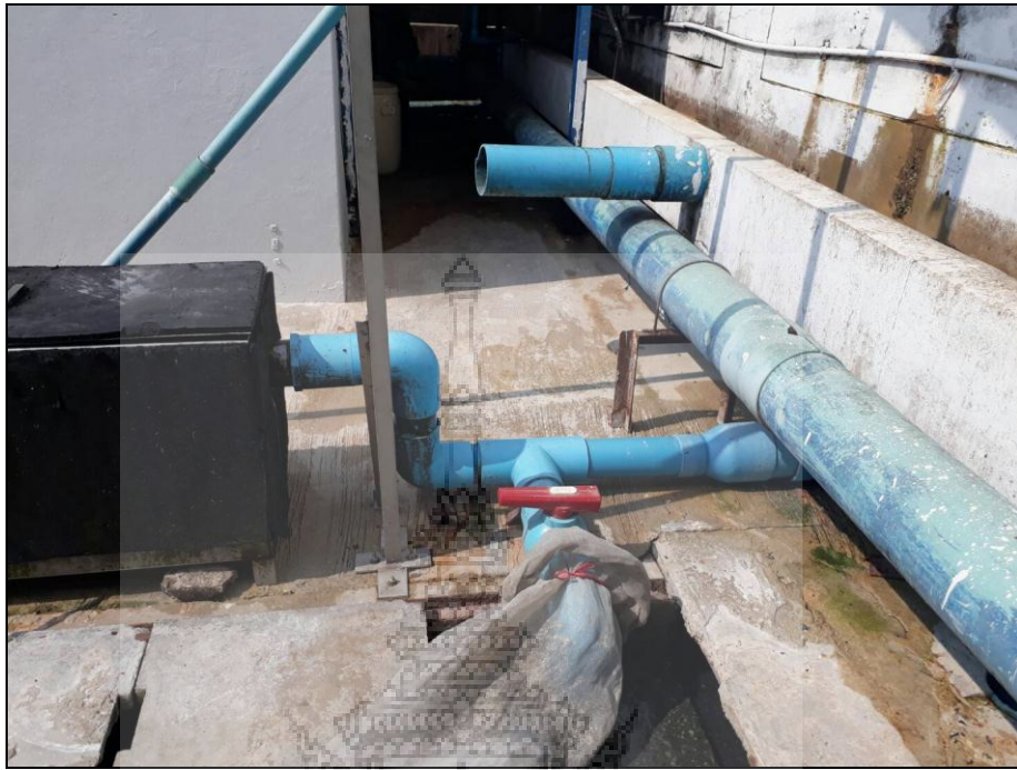
ภาพ 4.5 การต่อท่อน้ำเสียโดยใช้ท่อพีวีซี ขนาด 4 นิ้ว ต่อมาจากรางรึมน้ำเสียในไลน์ผลิต ตรงการของท่อจะใส่สามทางเพื่อต่อวาวส์ไว้เพื่อทำการปล่อยน้ำเสียลงรางได้ โดยตรงไม่ต้องผ่านเครื่องแลกเปลี่ยนได้
