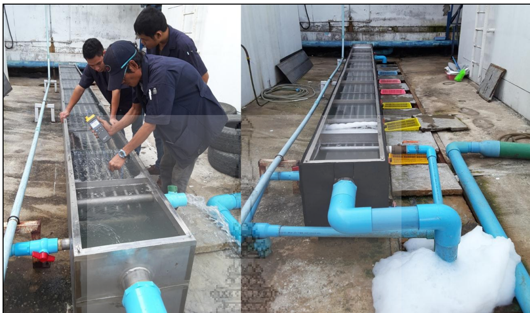
ภาพ 4.12 ทดสอบการใช้งาน โดยปล่อยให้ น้ำเสียเข้าสู่เครื่องแลกเปลี่ยนความร้อน และน้ำดีเข้าสู่ท่อ น้ำดี
