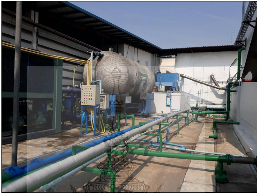
ภาพ 4.7 บริเวณของเครื่องทำน้ำเย็น บ่อพักน้ำเย็น และเครื่องแลกเปลี่ยนความร้อน อยู่ในบริเวณเดียวกันเพื่อสะดวกในการทำงาน อยู่ใกล้กับเครื่องทำน้ำเย็นที่มีปั๊มส่งน้ำจากบ่อพักน้ำเย็นมายังเครื่องทำน้ำเย็นแล้วไหลกลับไปเก็บไว้ในบ่อน้ำเย็นที่อุณหภูมิ 15°C ก่อนส่งไปใช้ในไลน์ผลิต
