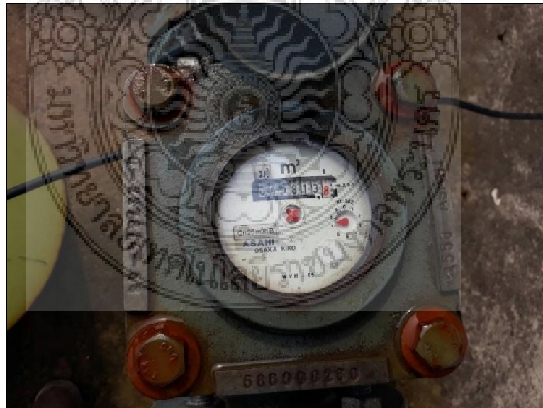
ภาพ 4.10 มิเตอร์วัดปริมาณการใช้น้ำ ตรวจสอบปริมาณการใช้น้ำในแต่ละวัน
