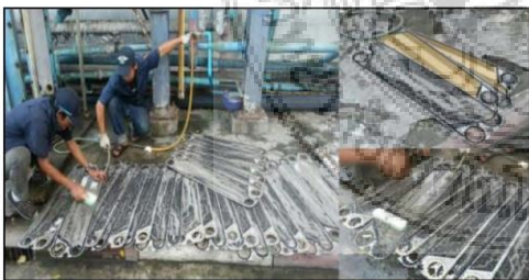
รูปที่ 2 การล้างเครื่องแลกเปลี่ยนความร้อนแบบ Plate Heat Exchanger ที่ต้องใช้ผู้เชี่ยวชาญในการถอดล้างทำความสะอาด
