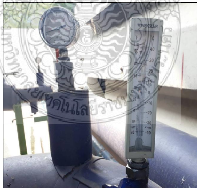
ภาพ 4.8 ความดันในระบบเครื่องทำน้ำเย็น เป็นการตรวจสอบการทำงานของเครื่องทำน้ำเย็น
