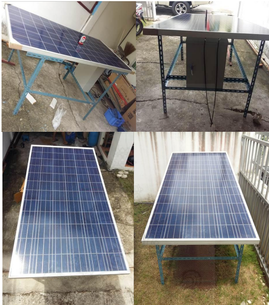
ภาพ 3.10 ประกอบแผงเซลล์แสงอาทิตย์กับส่วนโครงสร้าง
