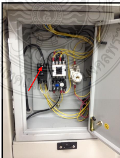
ภาพที่ ข-2 แสดงการตรวจสอบเบรกเกอร์
