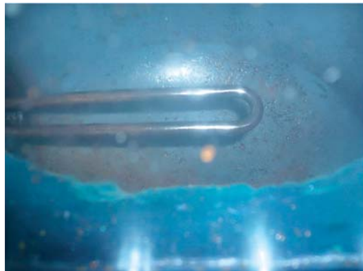
รูปที่ 7 แสดงการติดตั้งฮีตเตอร์ให้ความร้อนในถังแยกความชื้น
