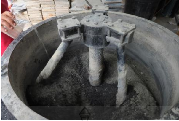
รูปที่ 3.12 การเติมน้ำประปาส่วนที่ 1 ลงในส่วนผสม
