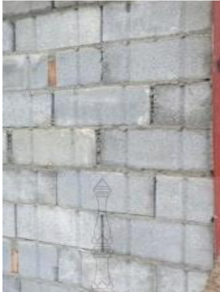
รูปที่ 4.18 ลักษณะของผนังที่ก่อด้วยคอนกรีตบล็อกผสมผงเซรามิกชนขอบเฟรม
