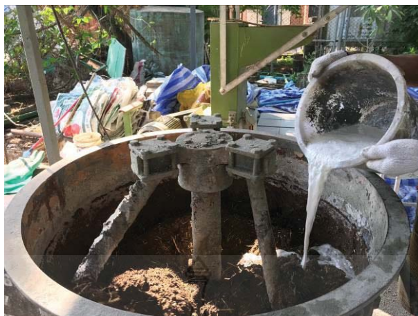
รูปที่ 3.36 การเทน้ำประปาผสมน้ำยากันซึม และน้ำยางพาราลงในเครื่องผสม
