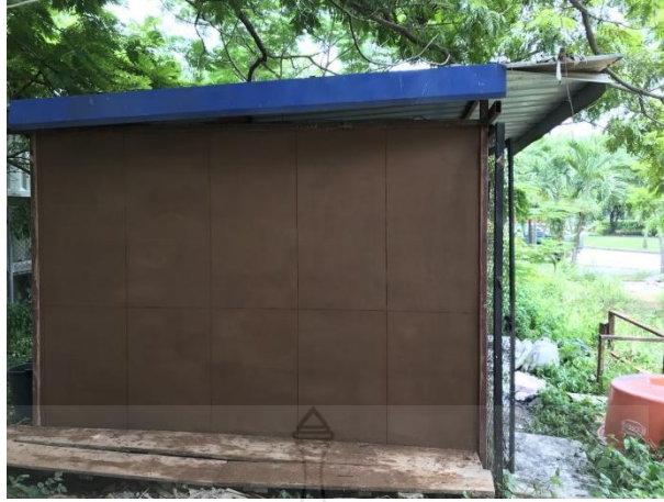
รูปที่ 72 ผนังบ้านดินสำเร็จรูปผสมน้ำยางพาราที่ติดตั้งเรียบร้อยแล้ว
