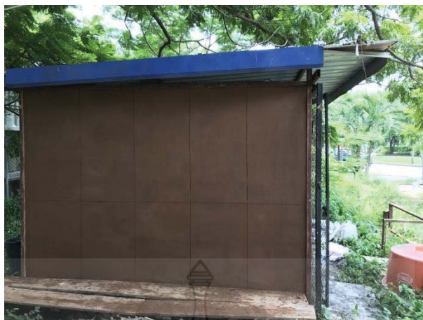
รูปที่ 4.11 ผนังบ้านดินสำเร็จรูปผสมน้ำยางพาราที่ติดตั้งเรียบร้อยแล้ว
