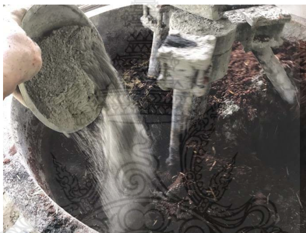
รูปที่ 3.34 การเทปูนซีเมนต์ลงในเครื่องผสม
