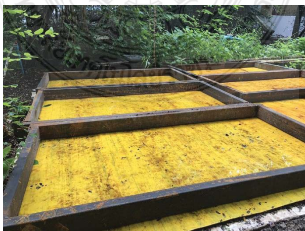
รูปที่ 3.11 แบบหล่อขนาด 60 \times 120 \times 15 เซนติเมตร
