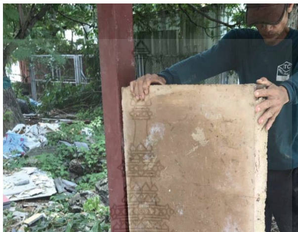
รูปที่ 4.9 การนำแผ่นผนังบ้านดินสำเร็จรูปผสมน้ำยางพารา อัตราส่วน R0.1 มาเชื่อมกับโครงเหล็กและแผ่นผนังบ้านดินสำเร็จรูปผสมน้ำยางพาราต่อไป
