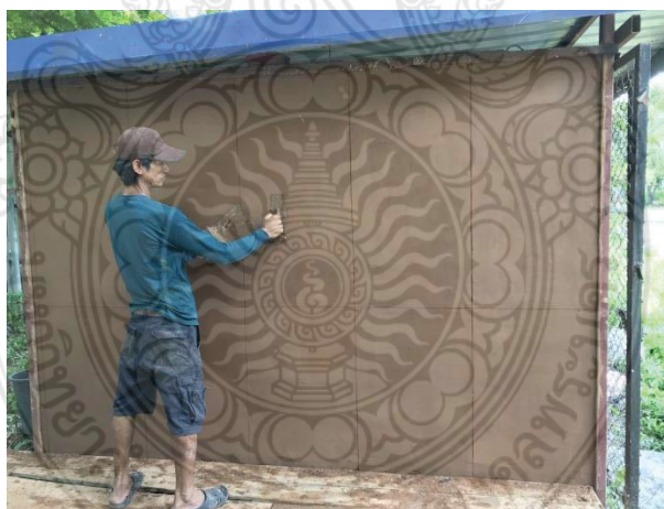
รูปที่ 4.10 การฉาบปิดร่องของแผ่นผนังบ้านดินสำเร็จรูปผสมน้ำยางพาราให้เรียบ
