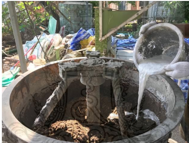
รูปที่ 32 การเทน้ำประปาผสมน้ำยากันซึม และน้ำยางพาราลงในเครื่องผสม
