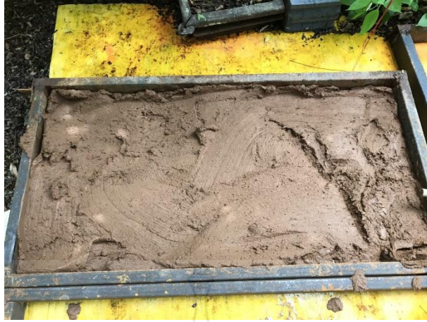
รูปที่ 39 การขึ้นรูปตัวอย่างผนังบ้านดินสำเร็จแบบหล่อขนาด 60x120x15 เซนติเมตร
