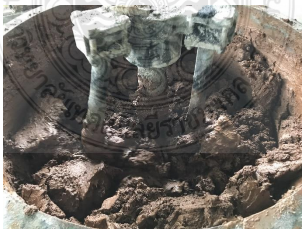
รูปที่ 33 การผสมส่วนผสมให้เข้ากันสำหรับนำไปเทลงในแบบหล่อ
