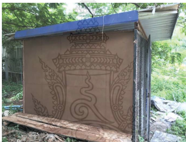
รูปที่ 4.12 ด้านข้างของผนังบ้านดินสำเร็จรูปผสมน้ำยางพาราที่ติดตั้งเรียบร้อยแล้ว
