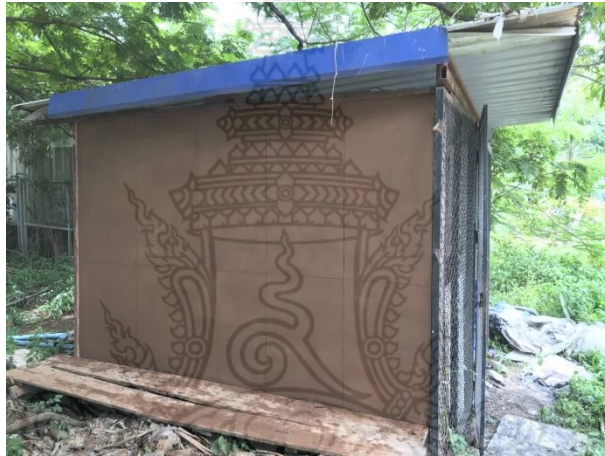
รูปที่ 73 ด้านข้างของผนังบ้านดินสำเร็จรูปผสมน้ำยางพาราที่ติดตั้งเรียบร้อยแล้ว
