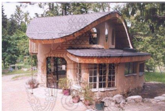
รูปที่ 2.1 ลักษณะภายนอกของบ้านดิน
