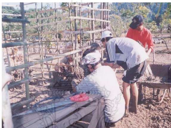
รูปที่ 2.7 โครงไม้ไผ่และการนำฟางที่คลุกดินมาหุ้มโครงไม้ไผ่
