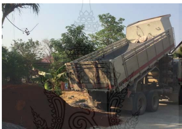
รูปที่ 3.1 การนำดินเหนียวมายังสถานที่ขึ้นรูปโครงการแผ่นผนังดินสำเร็จรูปผสมน้ำยางพารา
