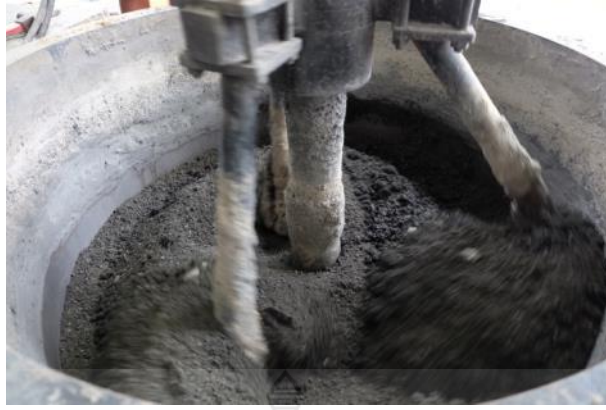
รูปที่ 13 การผสมปูนซีเมนต์ ทราย และเศษถนนยางมะตอยเหลือทิ้งด้วยเครื่องผสมคอนกรีต
