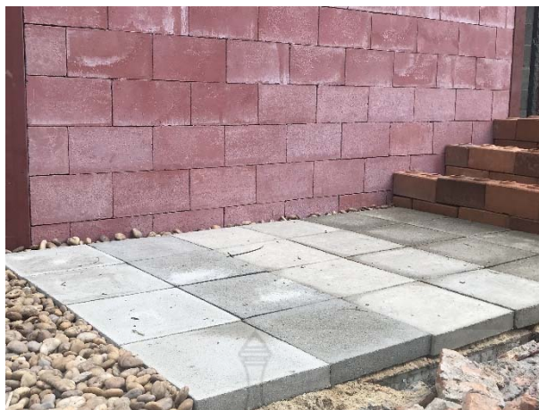
รูปที่ 4.11 ลักษณะการใช้งานแผ่นกระเบื้องคอนกรีตปูพื้นผสมเศษถนนยางมะตอยเก่า
