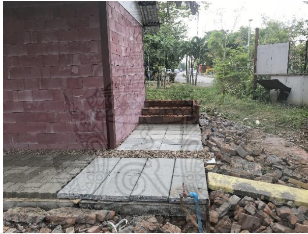
รูปที่ 35 บริเวณรอบอาคารที่มีการนำแผ่นกระเบื้องคอนกรีตปูพื้นผสมเศษถนนยางมะตอยเก่าไปใช้งานจริง
