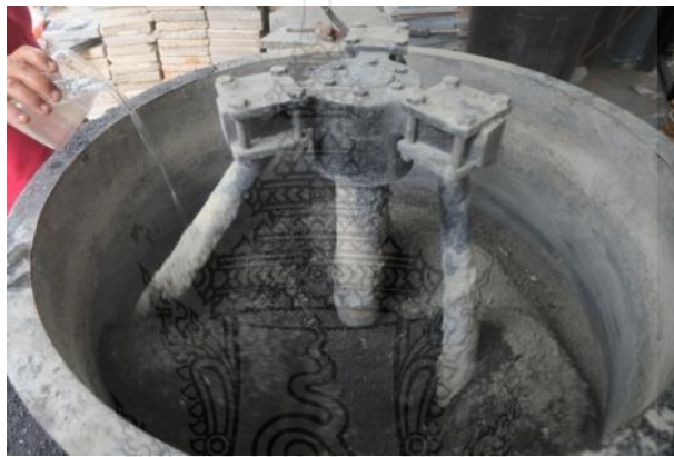
รูปที่ 14 การเติมน้ำประปาที่ผสมสารเร่งการก่อตัวแล้วลงในเครื่องผสมคอนกรีต
