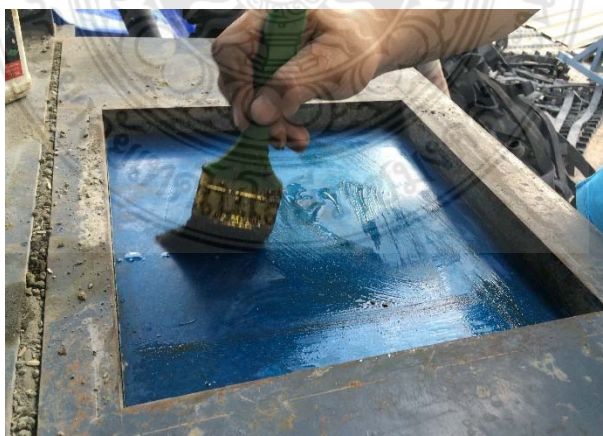
รูปที่ 3.9 แบบหล่อกระเบื้องคอนกรีตปูพื้น
