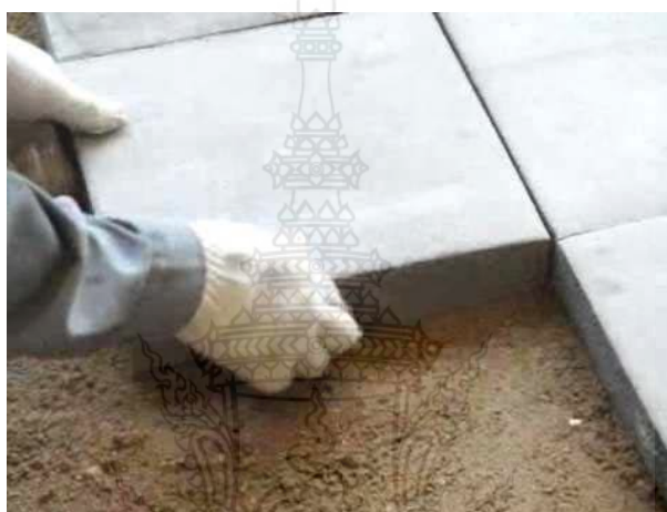
รูปที่ 1.4 การติดตั้งแผ่นกระเบื้องคอนกรีตปูพื้น
