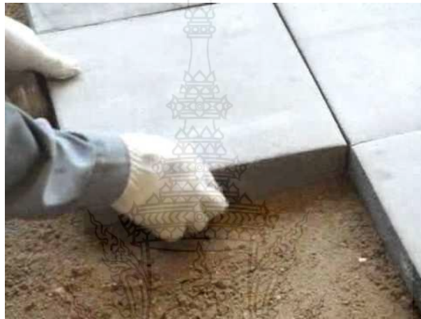
รูปที่ 4 การติดตั้งแผ่นกระเบื้องคอนกรีตปูพื้น
