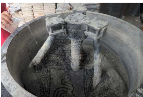
รูปที่ 3.8 การเติมน้ำประปาที่ผสมสารเร่งการก่อตัวแล้วลงในเครื่องผสมคอนกรีต
