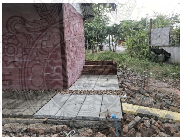
รูปที่ 4.10 บริเวณรอบอาคารที่มีการนำแผ่นกระเบื้องคอนกรีตปูพื้นผสมเศษถนนยางมะตอยเก่าไปใช้งานจริง
