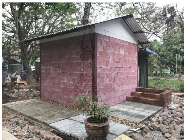
รูปที่ 4.9 การนำแผ่นกระเบื้องคอนกรีตปูพื้นผสมเศษถนนยางมะตอยเก่าไปใช้งานจริง
