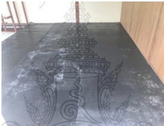
รูปที่ 62 ลักษณะการปูพื้นของแผ่นกระเบื้องยางธรรมชาติผสมพลาสติกอีวีเอที่มีคุณสมบัติหน่วงไฟสูตรต่างๆ
