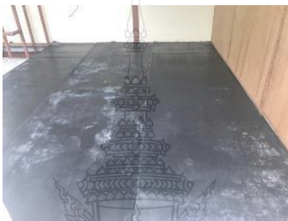
รูปที่ 4.13 ลักษณะการปูพื้นของแผ่นกระเบื้องยางธรรมชาติผสมพลาสติกอีวีเอที่มีคุณสมบัติทนวงไฟสูตรต่างๆ
