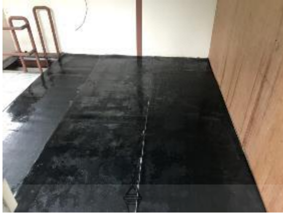
รูปที่ 64 พื้นผิวที่มีการปูหรือติดตั้งด้วยแผ่นกระเบื้องยางธรรมชาติผสมพลาสติกอีวีเอที่มีคุณสมบัติหน่วงไฟสูตรต่างๆ
