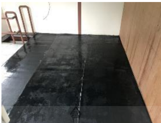
รูปที่ 4.15 พื้นผิวที่มีการปูหรือติดตั้งด้วยแผ่นกระเบื้องยางธรรมชาติผสมพลาสติกอีวีเอที่มีคุณสมบัติหน่วงไฟสูตรต่างๆ
