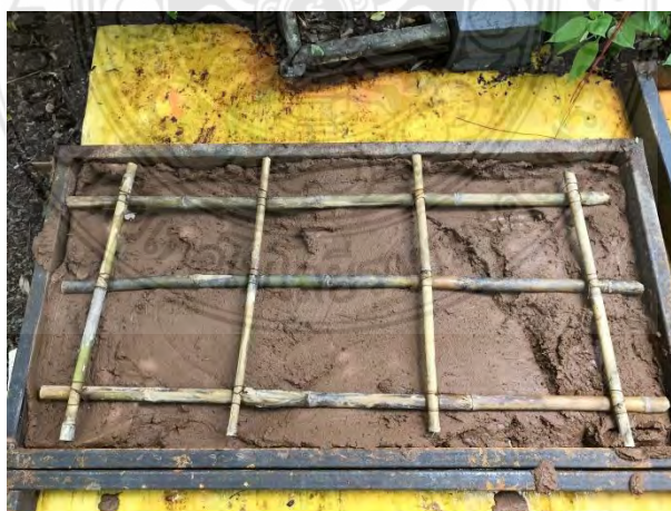
รูปที่ 3.42 การเสริมไม้รอกลงในตัวอย่างผนังบ้านดินสำเร็จในแบบหล่อขนาด 60x120x15 เซนติเมตร
