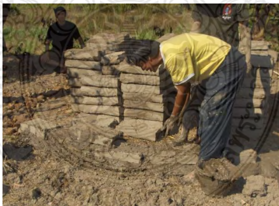
รูปที่ 2.6 การก่ออิฐดินดิบ
