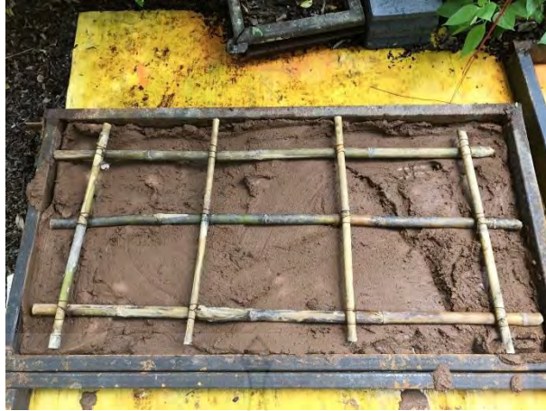
รูปที่ 32 การเสริมไม้รอกลงในตัวอย่างผนังบ้านดินสำเร็จในแบบหล่อขนาด 60x120x15 เซนติเมตร
