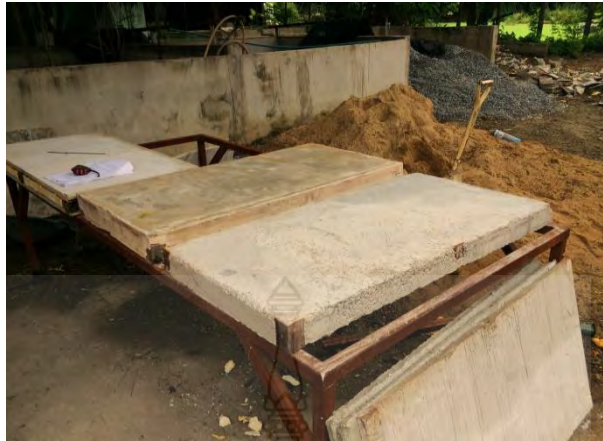
รูปที่ 50 การวางผนังบ้านดินสำเร็จรูปขนาด 60x120x15 เซนติเมตรเพื่อทดสอบความแข็ง
