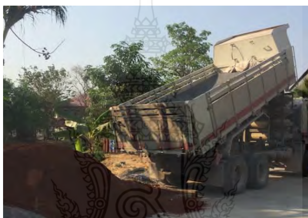
รูปที่ 3.1 การนำดินเหนียวมายังสถานที่ขึ้นรูปโครงการแผ่นผนังดินสำเร็จรูป
