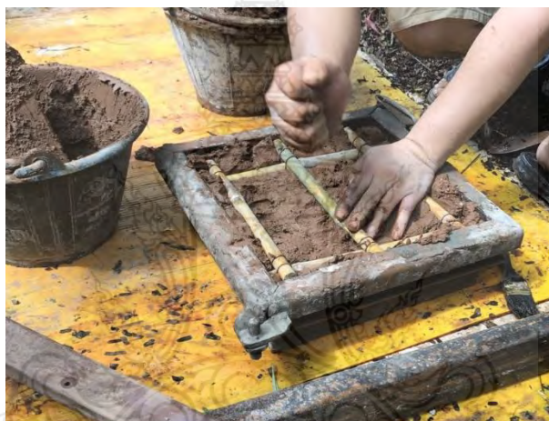
รูปที่ 3.38 การนำส่วนผสมไปอัดขึ้นรูปในแบบหล่อ พร้อมทั้งเสริมไม้รวก
